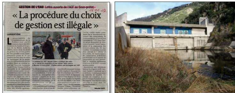
Figure 39: coupure de presse concernant l'ACF (source : site internet ACME) et photographie du barrage du Pont de Veyrières (source: le site internet du comité français des barrages et réservoirs)
