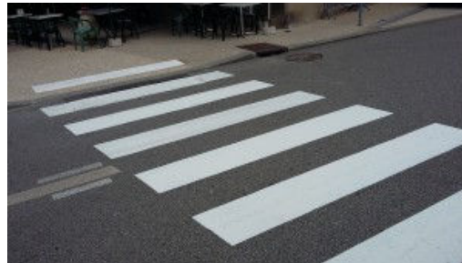
(a) Passage piéton
