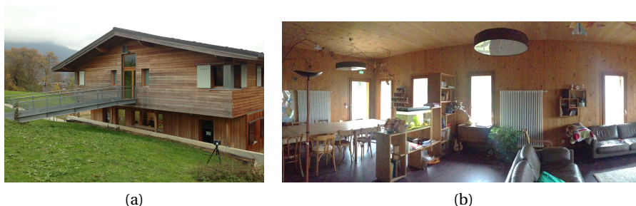
FIGURE 1.1 – Bâtiment construit en CLT : (a) vue de l'extérieur, (b) vue de l'intérieur.
