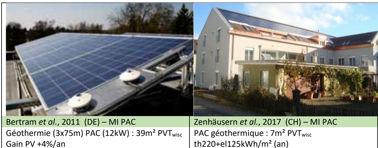
Figure 12 : Installations monitorées pour le segment maisons individuelles (MI) en couplage PVT + pompe à chaleur (PAC)
