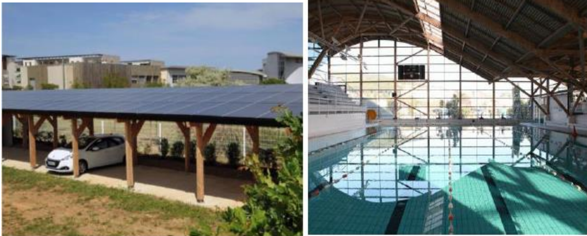
Figure 243 : Photographie de l'ombrière PVT pour la piscine couverte municipale de Sète
