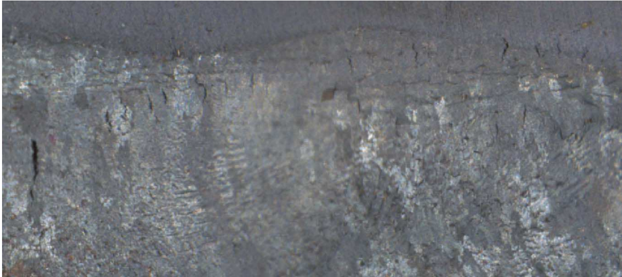
Figure III.7 : Des fissures par liquation pour la nuance F (44 ppm)
