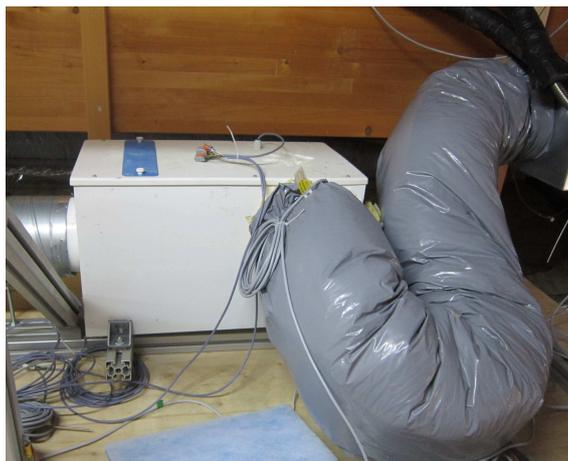
FIGURE 2.3 – Caisson de ventilation MAXI du fabricant Ventilairsec installé dans les combles de la maison I-BB.
