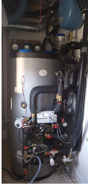
FIGURE 2.6 – Ballon sanitaire de 400 L de volume placé dans le cellier au RDC de la maison I-BB.
