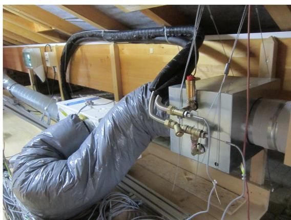
FIGURE 2.4 – Batterie eau chaude intégrant un échangeur de chaleur entre le fluide caloporteur provenant des panneaux solaires thermiques et l'air insufflé dans le bâtiment.
