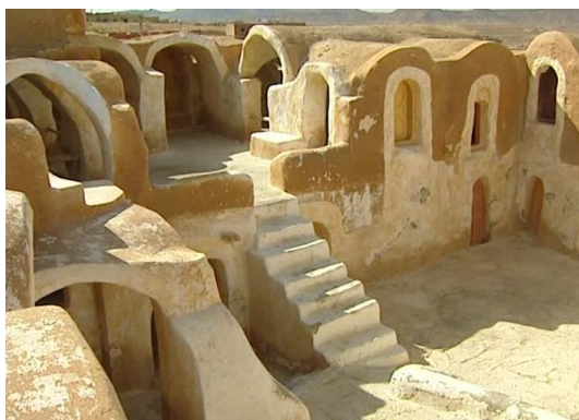
A : La partie reconstruite de ksar Haddada
