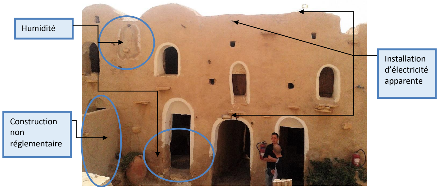
Figure 43 : La partie reconvertie en hébergement à ksar Haddada
