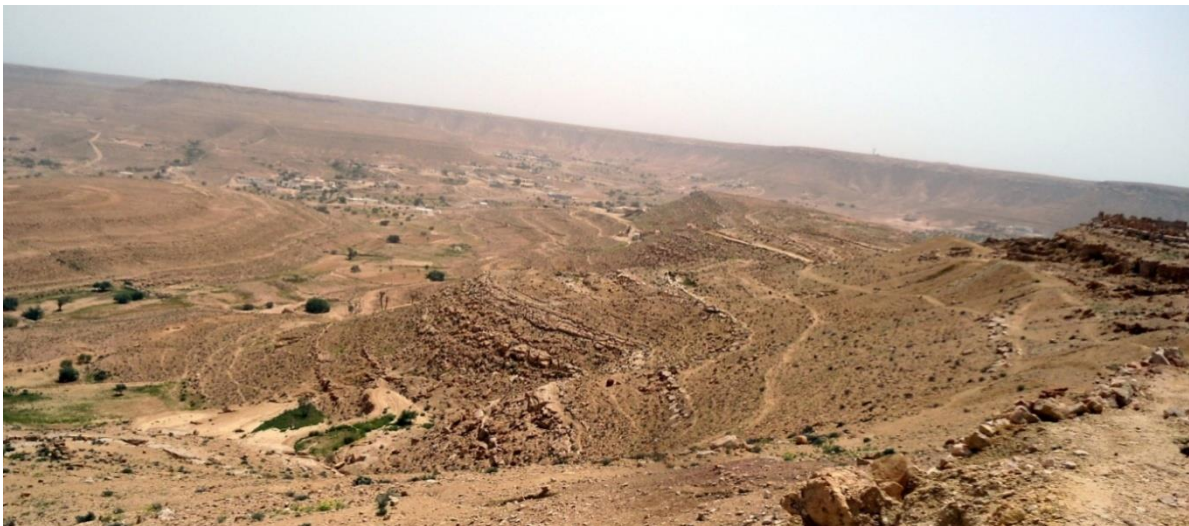
Figure 11: Les digues en terre des barrages (jessour) du ksar Morabiti. (Source : Ellouze, 2017)
