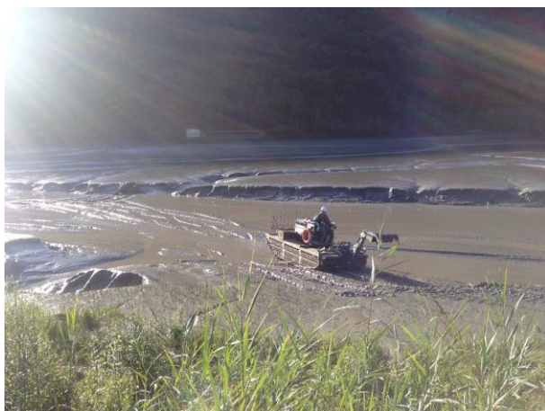
Figure 3.13 : Mobitrac en mouvement entre la zone de prélèvement et la zone de dépôt temporaire
