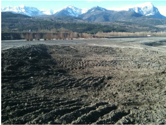
Figure 3.7 : Zone de prélèvement des sédiments dans la partie amont de la retenue
