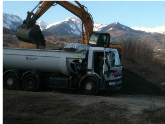
Figure 3.8 : Chargement en vrac du camion de transport des sédiments fins SPO
