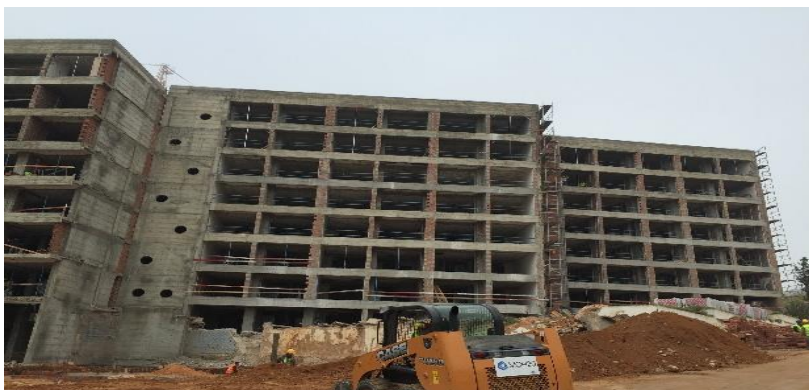
Figure 82. Béton préfabriqué à l'hôtel Ritz Carlton, Tunis (Essouaid, 2015)
