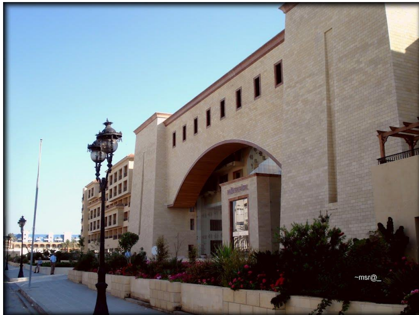
Figure 54. Hôtel Movenpick Ressort Sousse après la rénovation (Essouaid, 2015)
