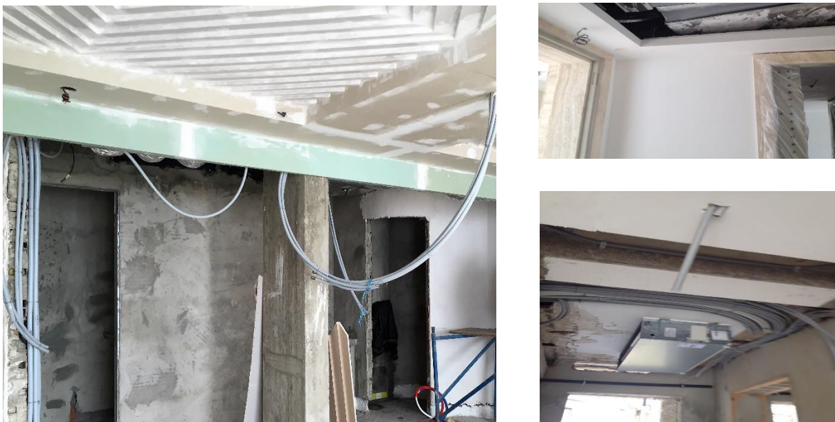
Figure 83. Stratégies vertes pour l'étape de démolition de l'hôtel Ritz Carlton Tunis, après la fin du cycle de vie. (Essouaid, 2015)
