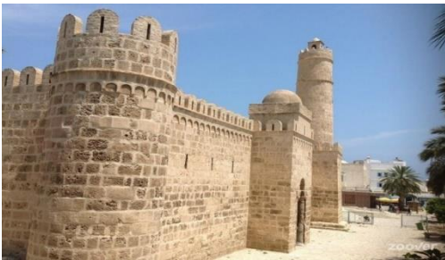
Figure 25. Le Ribat de Sousse (Sousse Demain, 2011)
