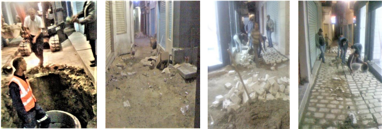
Figure 45. Les différents travaux entrepris à travers la Rue Al Aghalba (Essouaid, 2013)
