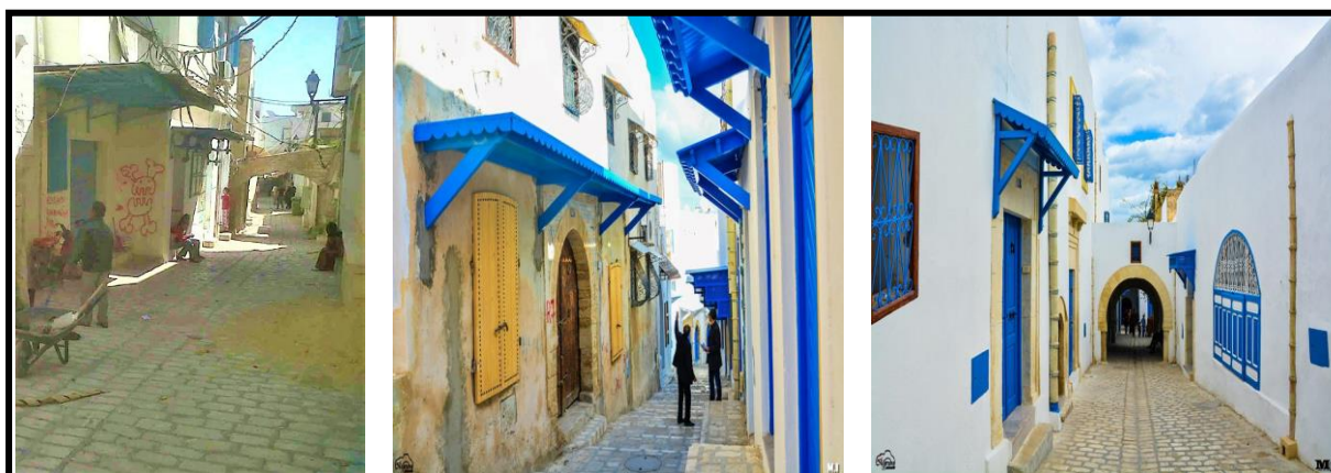
Figure 43. Etat avant et après les travaux (Essouaid, 2014)
