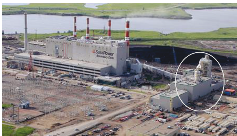
Figure 3 : Unité de captage de Boundary Dam (unité de captage entourée)
