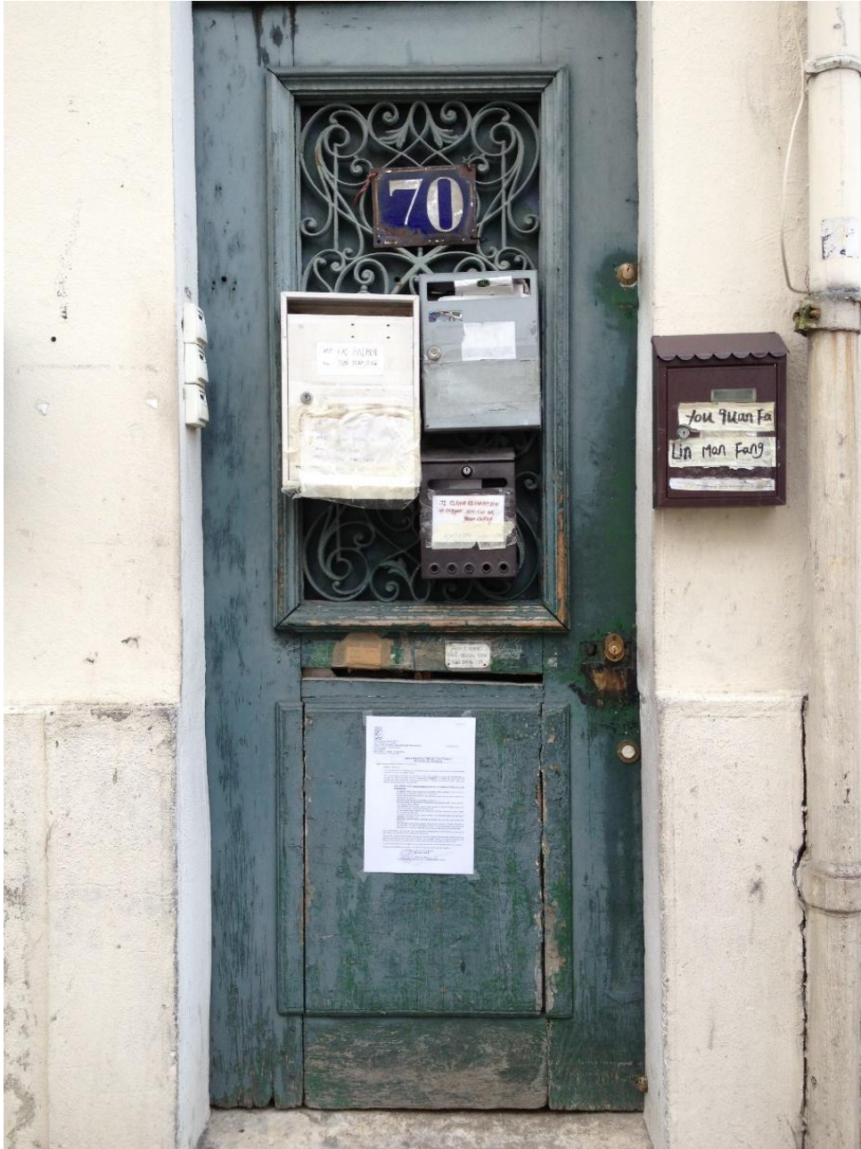
Figure 24 Porte d'entrée de l'immeuble n°70
