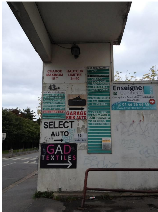
Figure 8 Entrée du parc résidentiel La Noue
