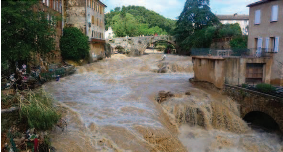
Figure 1.5 : Crue de la Nartuby à Trans-en-Provence suite à un épisode Méditerranéen, le 15 juin 2010. Le débit de pointe lors de cet évènement a été estimé entre 360 et 520m 3 /s à Trans-en-Provence selon Payrastre et al. (2012). © Cantet Philippe / Irstea
