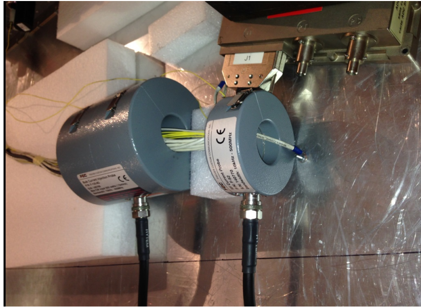
Figure 4.37 – Mesure du courant sur le blindage via la queue de cochon
