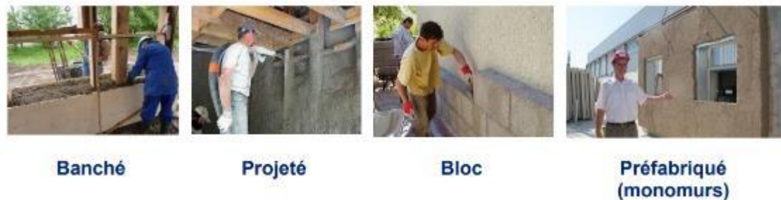
Figure I-10. Différentes techniques de mise en œuvre [THO15]
