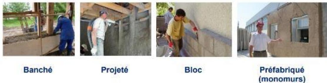
Figure I-10. Différentes techniques de mise en œuvre [THO15]
