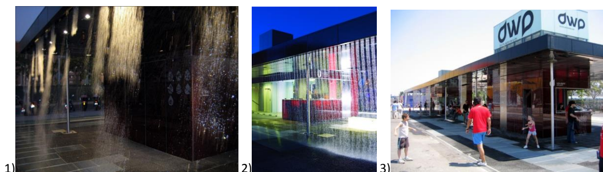
Figure 73 Zone d'influence du dispositif. A gauche et au milieu : Courants d'air déplaçant le rideau d'eau. Sources : https://www.flickr.com/photos/stuardo/2688261466/ (1) et http://www.architectureoflife.net/en/architecture-that-senses-and-responds-digital-water-pavillion-by-mit/ (2). A droite : Cette photo pourrait être prise au moment où le garçon est sorti du pavillon en courant et lorsqu'il regarde la fille à l'intérieur en train de toucher le rideau. On voit un homme passant entre les deux à l'extérieur du pavillon. Cela renvoie à une situation qui aurait pu se passer : un passant indifférent qui se trouve entre les visiteurs jouant vivement avec le rideau doit prêter attention à leurs mouvements afin de passer en évitant la collision, et cela peut contribuer à attirer son attention sur le dispositif. Aussi initialement, du fait que le pavillon offre de l'ombre à l'extérieur, le passant peut être invité par celle-ci et marcher en longeant le mur. La zone occupée par les activités du rideau est beaucoup plus large que l'épaisseur de la paroi éphémère. Source : https://www.flickr.com/photos/macthai/2790418809/ (liens consultés en mars, 2017).
