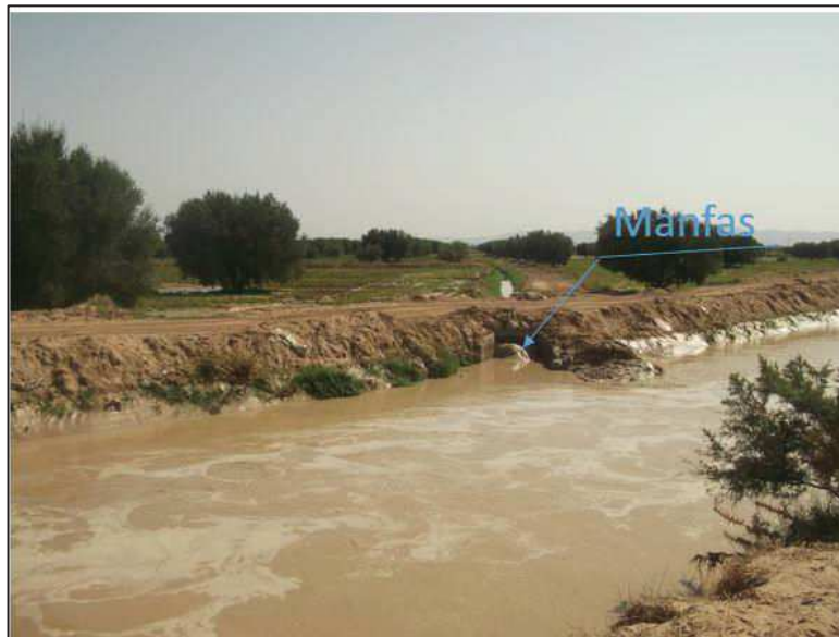
Figure 18. Manfas au niveau d'un canal en terre
