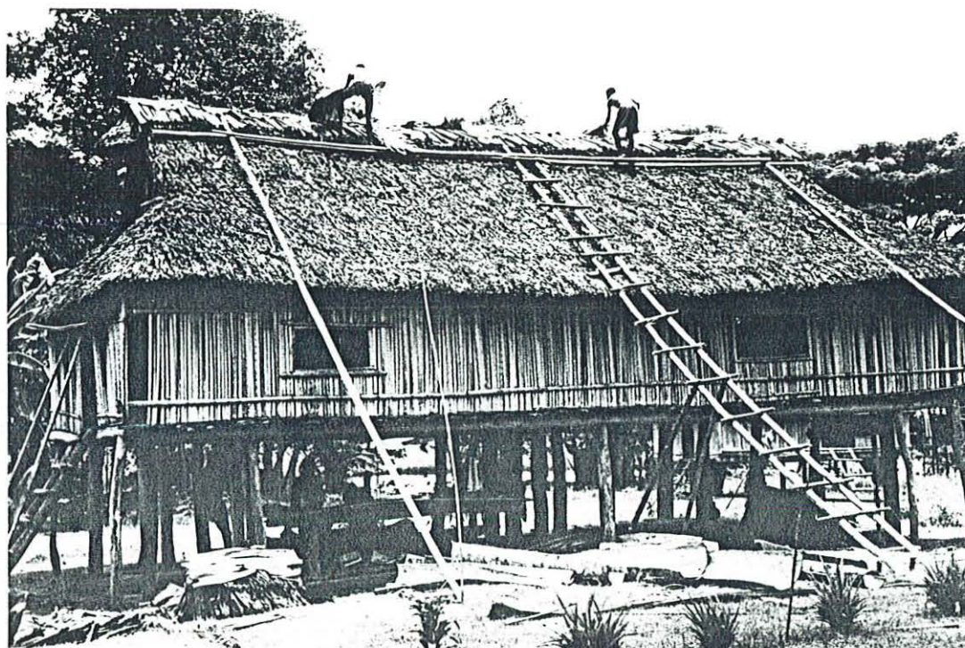
Photo. n°205 - Des hommes de Aïbom placent des morceaux d'écorce de mam mandje ( Althoffia pleiostigma ) et des grandes feuilles d'arbre à pain comme protection de faitage. On remarquera la technique de fixation de l'échelle provisoire.
