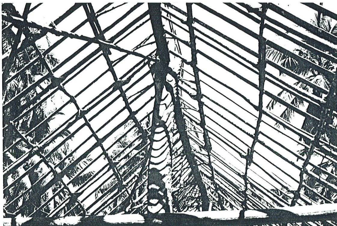
Photo. n°195 - Structure de la charpente de toiture d'une maison cérémonielle en construction (Aïbom, 1988).
