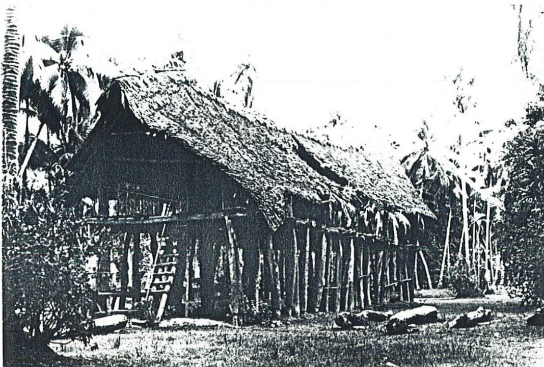
Photo. n°222 - Maison Wolimbi de Kanganaman, en 1986, après la destruction du pignon ndamangeko , suite au tremblement de terre de 1980.
