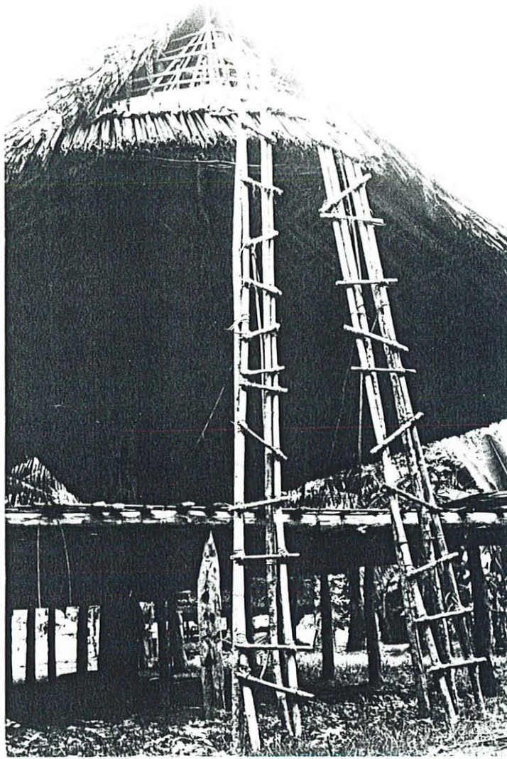
Photo. n°206 - Pignon d'une maison du village d'Avatip en cours de fabrication (1986). Remarquer les deux échelles de travail.
