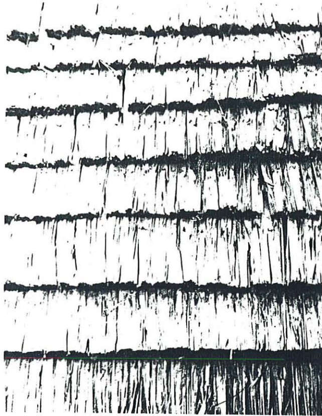
Photo. n°217 - Gros plan sur une partie de la cloison suspendue entourant la maison Payembit de Palimbei.
