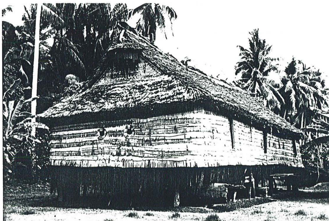
Photo. n°102 (A et B) - Maison cérémonielle Nanguimbit à Aïbom dont les cloisons extérieures bicolores sont réalisées avec des feuilles de palmier sagoutier et des feuilles de bambou tia (A). Détail du pignon (B).
