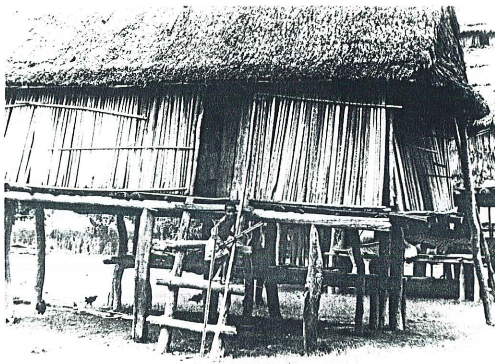
Photo. n°227 - Maison de Palimbei avec une cloison extérieure en rachis de feuilles de sagoutier.
