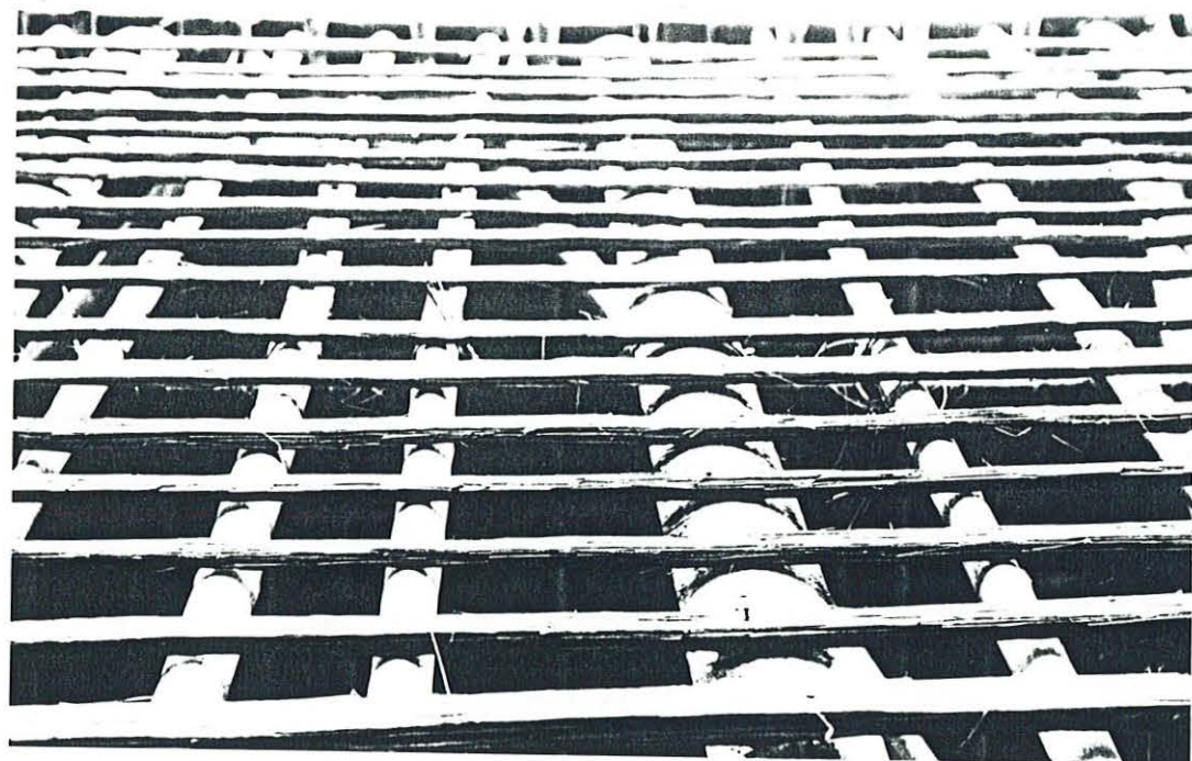
Photo. n°196 - Voligeage de la toiture de la nouvelle maison de Kusodemi à Abusatngeï.
