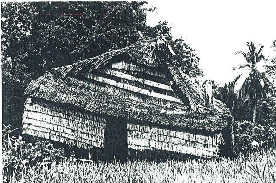
Photo. n°89 - La même maison détruite par un tremblement de terre. Palimbeï (1987).
