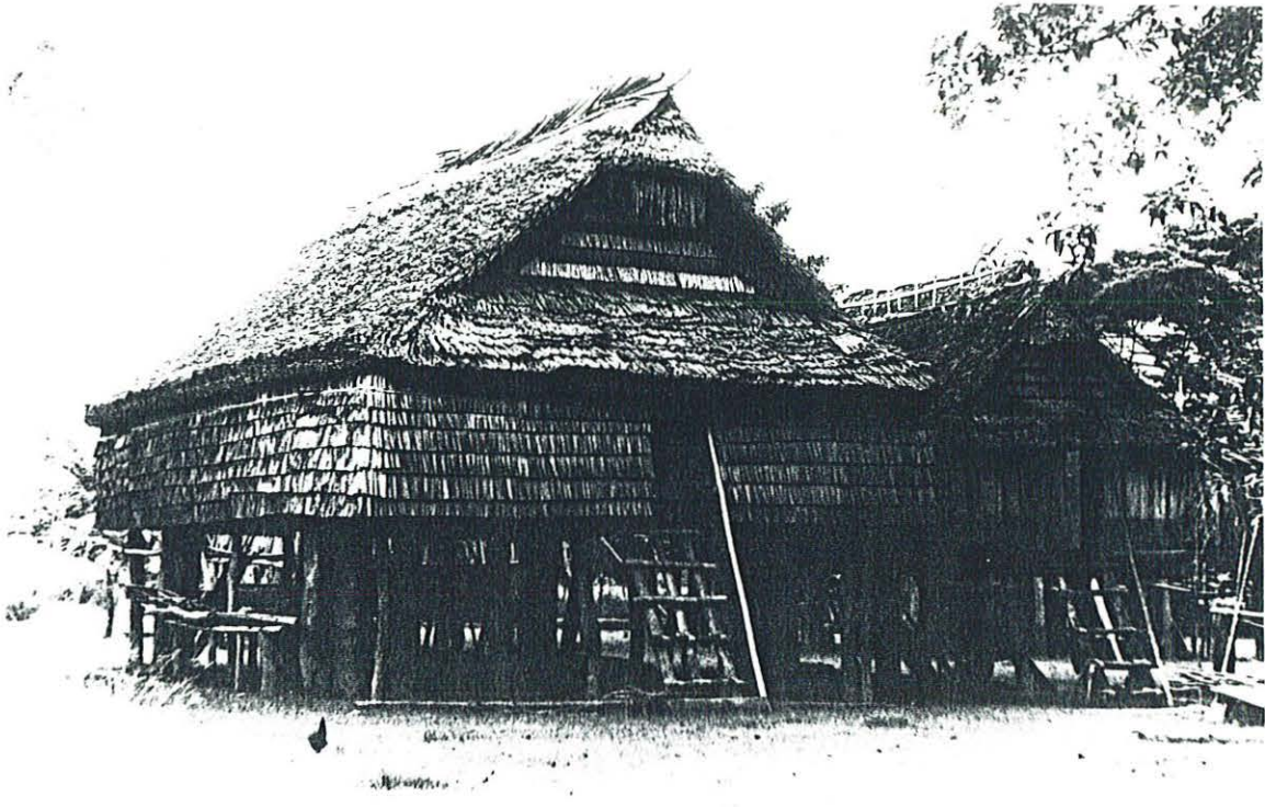
Photo. n°88 - Belle maison familiale récemment achevée de construire. Palimbeï (1980).
