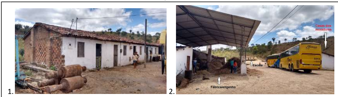
Figura 13: 1. Casas de moradores no Engenho Mandaú; 2. Vista da fábrica com escola
