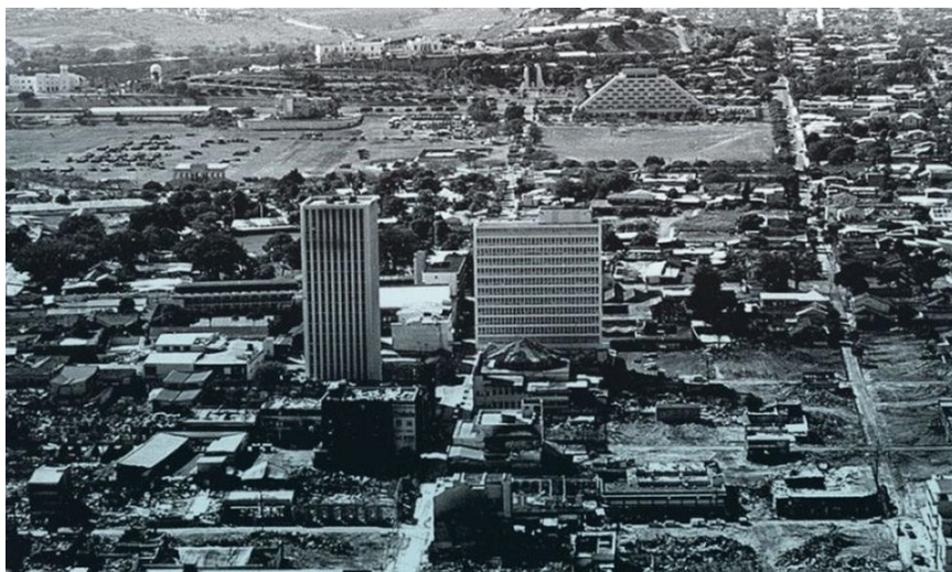
Imagen 4 Vista de Managua después del terremoto. Fuente: elnuevodiario.com.ni
