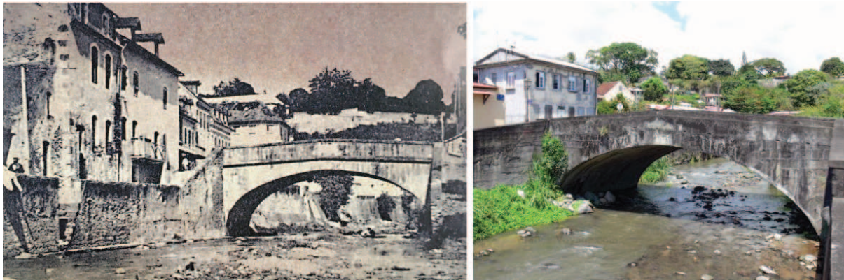
Figure 56 : Photographies du pont Roche de Saint-Pierre en 1902 et aujourd'hui 127
