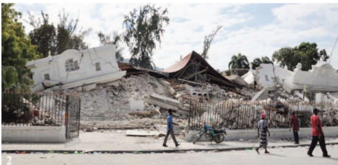
Figure 41 : Photographies des destructions des palais législatif et de justice à Port-au-Prince après le séisme du 12 janvier 2010 ; photographie n°1 : le palais législatif et photographie n°2 : le palais de justice 108
