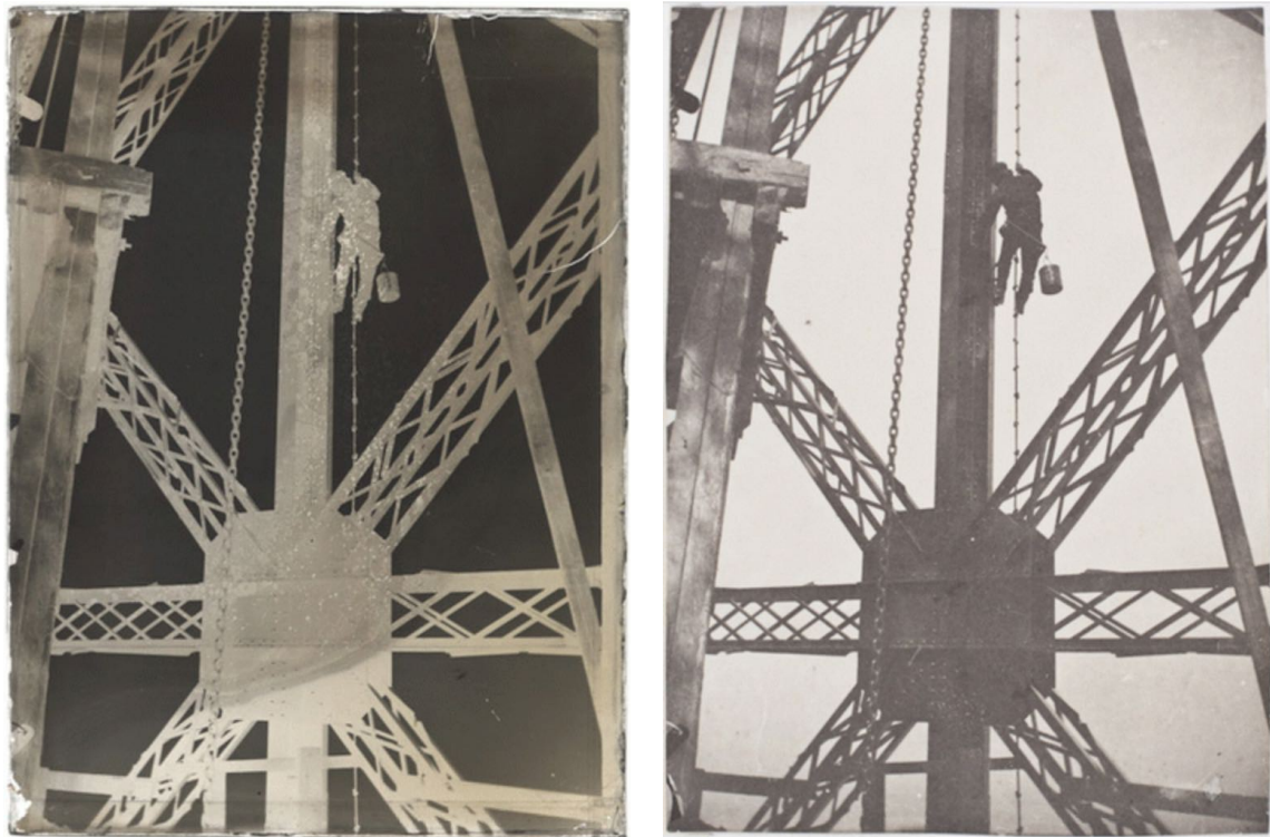
Fig. 3.11 Henri Rivière, La tour Eiffel - Peintre sur une corde à nœuds le long d'une poutre verticale, au-dessus d'un assemblage de poutres , 1889, négatif verre au gélatino-bromure d'argent (gauche) et épreuve argentique à partir d'un négatif verre (droite), 12 x 9 cm ©Musée d'Orsay ©ADAGP - photo musée d'Orsay / RMN
