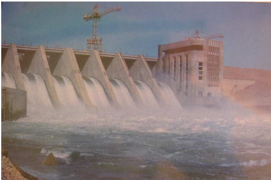
Figure 31 : Le barrage de l'Euphrate en plan serré qui ne permet pas de distinguer le nombre total de conduites (il n'y en a que huit) 369
