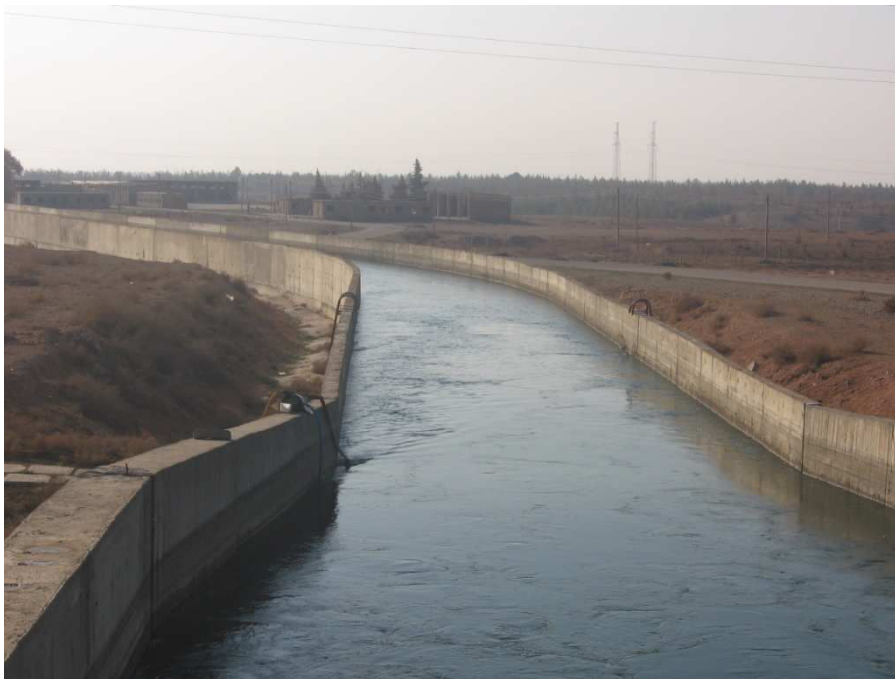
Figure 50 : Le canal principal, seule entrée d'eau dans le réseau. Cliché : Roman-Oliver Foy, janvier 2009
