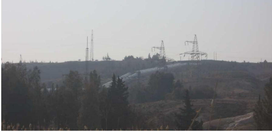
Figure 49 : Deux tubes blancs remontent quotidiennement l'eau du lac au périmètre. Cliché : Roman-Oliver Foy, janvier 2009
