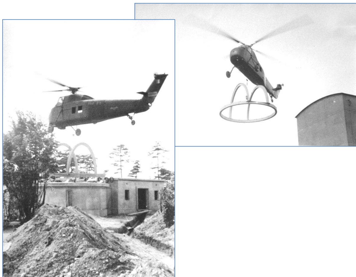
Fig. 13 Mise en place de la charpente métallique d'une coupole, 20 septembre 1963 55 .
