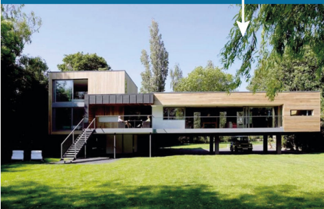
Photo 68 : maison reposant sur des piliers ancrés dans le sol. Source : J. Pardey, 2009
