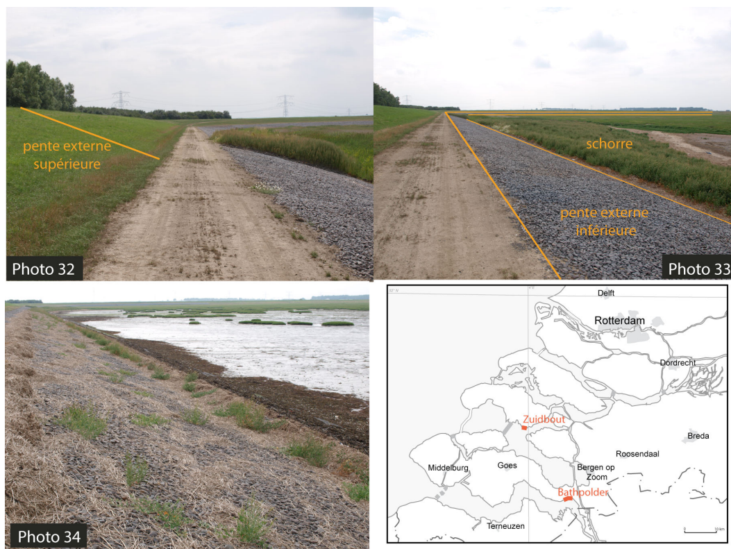
Photos 32 à 34 : revêtement des pentes externes de digues avec Elastocoast à Bathpolder.
