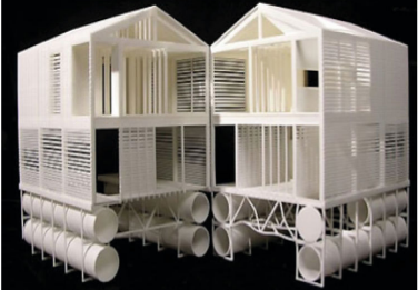
Figure 62 : construction amphibie. Principe : le bâtiment repose sur des flotteurs étanches en polyéthylène. Source : Architectes MOS.
