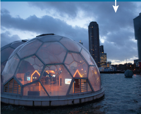
Photo 67 : Pavillon flottant de Rotterdam. Principe : la dalle du bâtiment est composée de couches de polystyrène expansé alterné avec des couches de béton. Source : S. Gueben-Venière, 2013.
