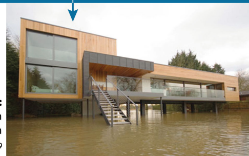
Photo 69 : la même maison en période d'inondation. Source : J. Pardey, 2009
