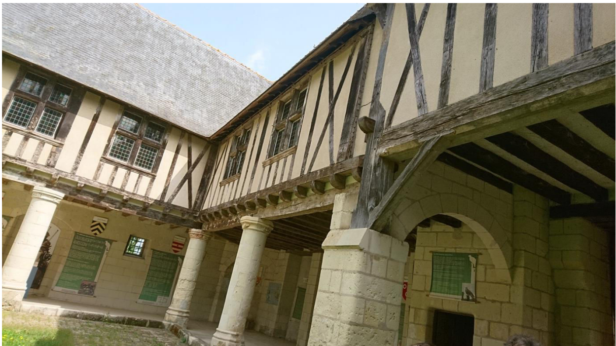
Figure 6 : Vue rapprochée de la liaison entre les structures de pierre et de bois.
