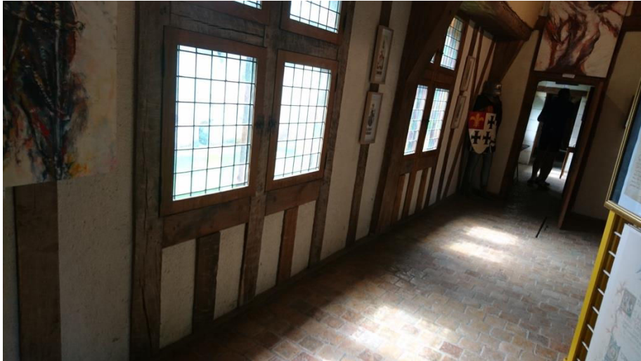
Figure 7 : Vue de l'intérieur de la structure de 1446.
