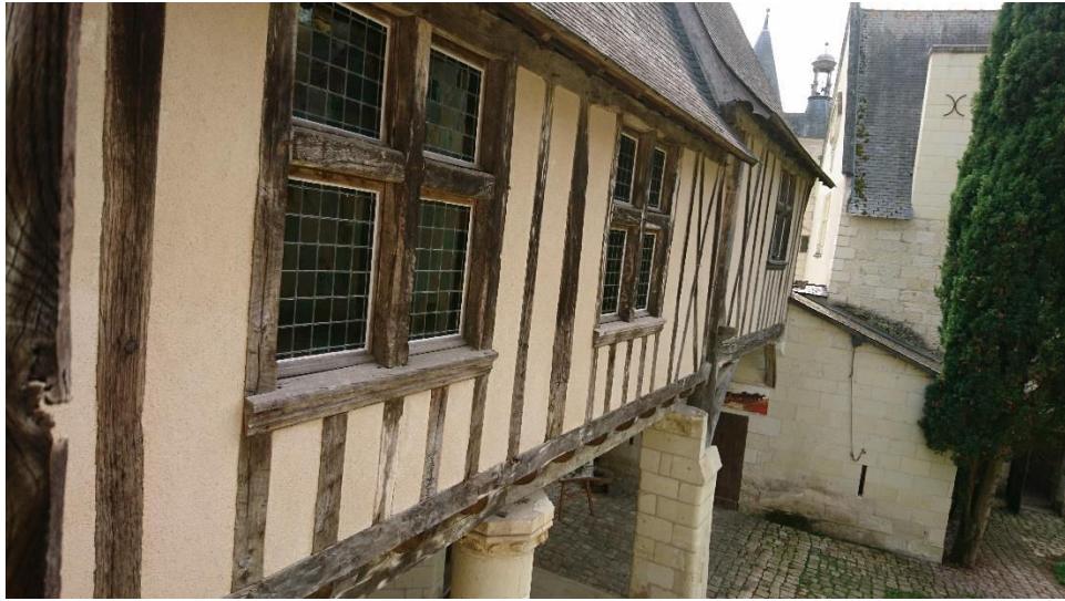
Figure 5 3: Structure en bois du Manoir de Launay (vue de l'étage)
