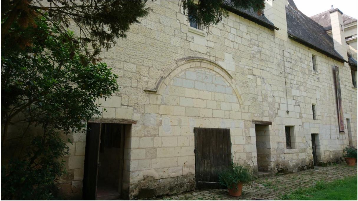
Figure 4 : Entrée de la cuisine du logis (cour intérieure).
