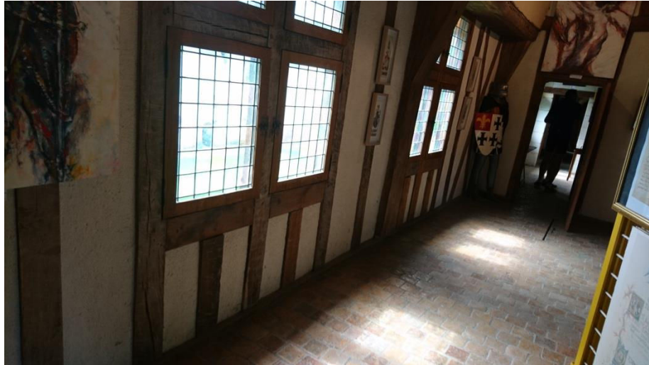
Figure 7 : Vue de l'intérieur de la structure de 1446.
