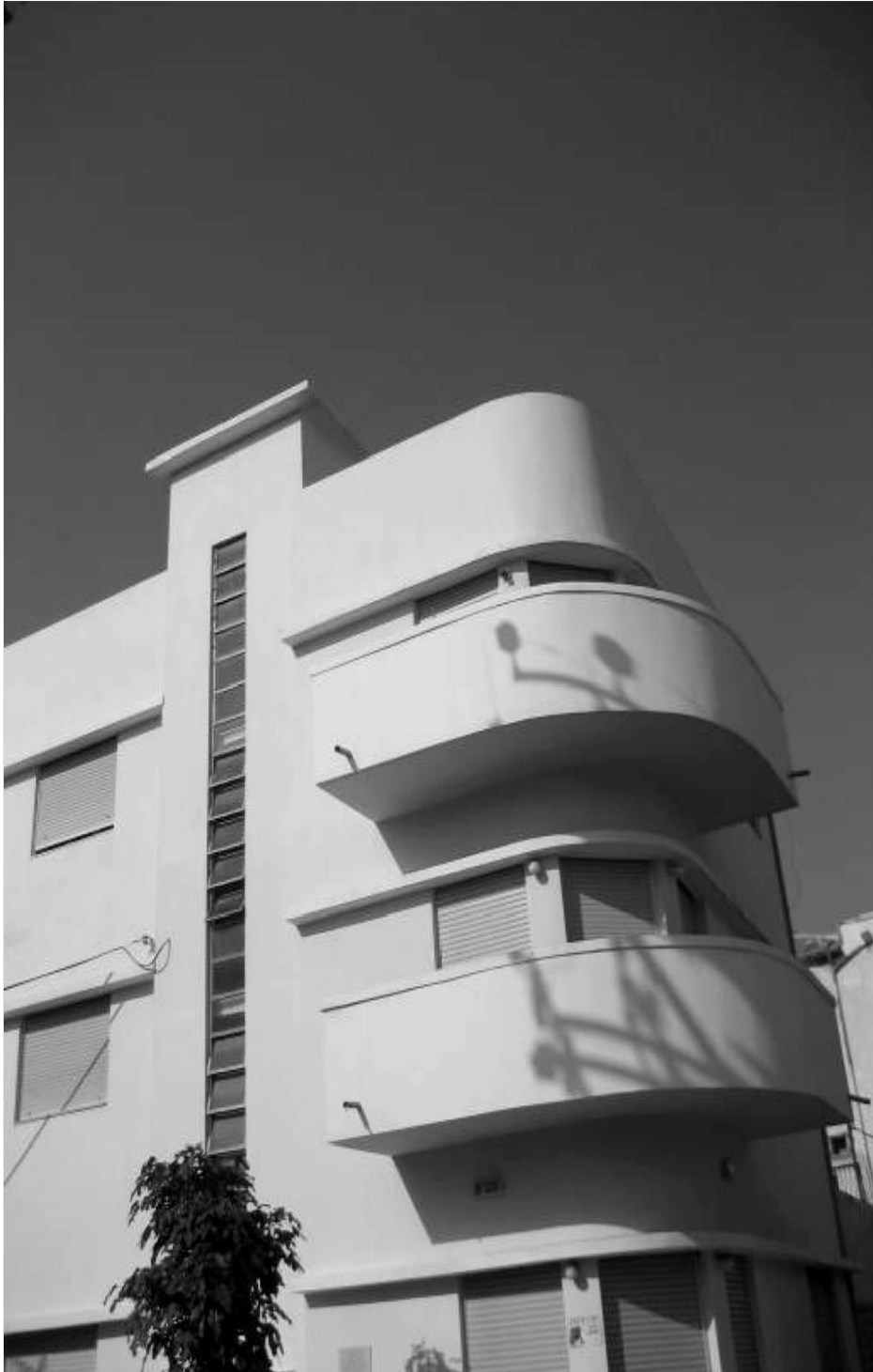
Figure 48: Fenêtre en bande horizontale des éléments caractéristiques de l'architecture de la Ville Blanche. Construction typique (37 rue Har Tabor). Photo : Jérémie Hoffmann 2011
