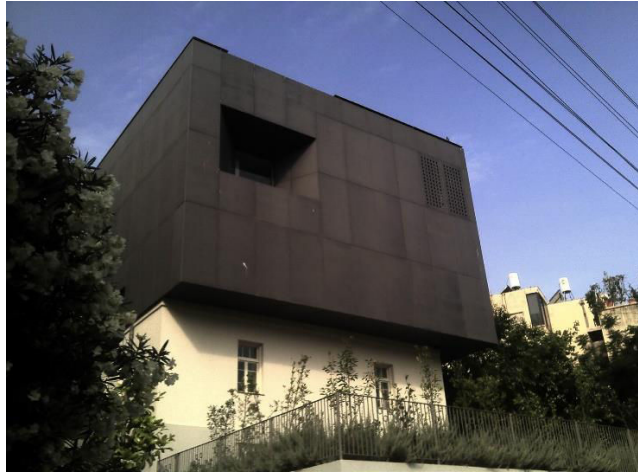
Figure 246: Galerie sur l'ancienne marie de la ville (Beit Hair), place Bialik, Architectes: Efrat- Kowalski, 2009, Photo: Jeremie Hoffmann, 2013
