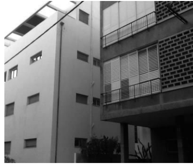
Figure 129: Deux générations d'architecture : la Ville blanche (à gauche : le 9, rue Gordon, architecte Dov Carmi, 1934) et la Ville Grise (à droite : architecte inconnu, construction typique des années 60 à Tel Aviv) photo : Jérémie Hoffmann, 2011
