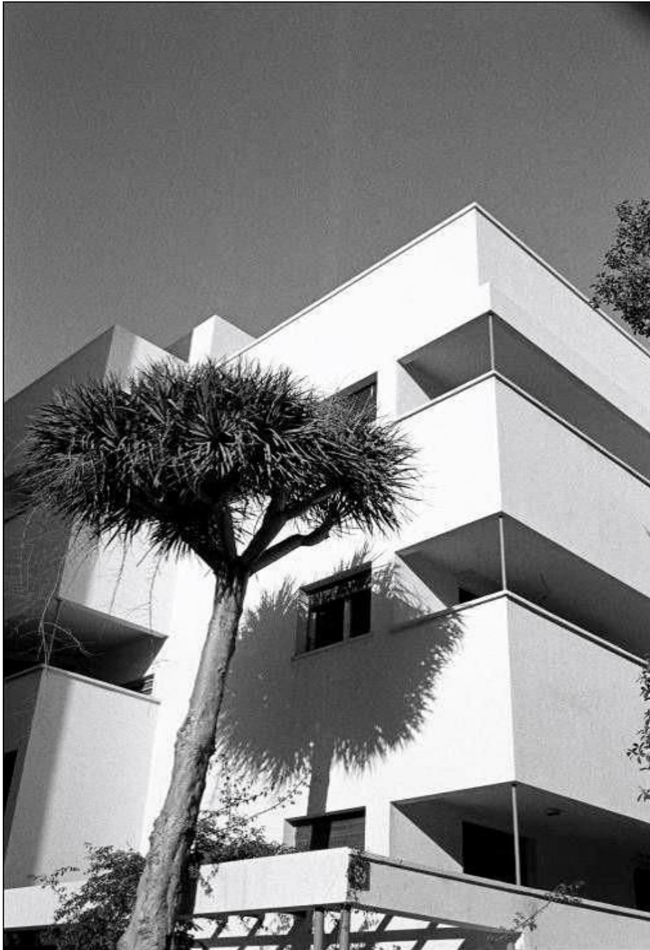
Figure 46: Composition de balcons creusés dans la masse générale. Beit Liebling, 21 rue Idelson, architecte : Dov Carmi, 1936. Photo : Jean Baptiste Avril 2009
