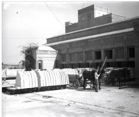
Figure 156: L'usine de briques de silicate, 1933. Photo : Zéev Alexandrovic (dans Gofna, 2010)
