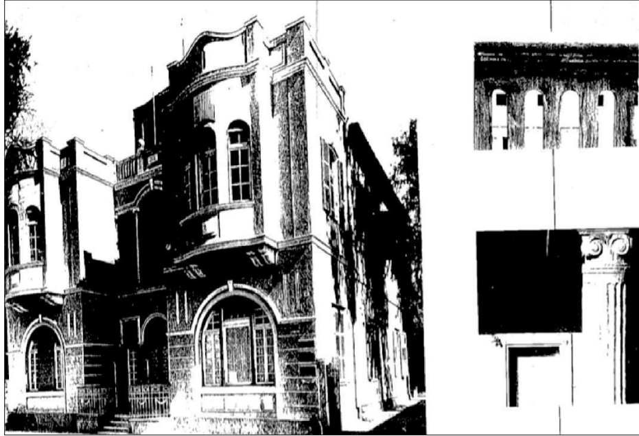
Figure 123 : À gauche : Beit Litwinski, Vue du Nord-Ouest, non datée (probablement dans les années 30-40) A droite : Détail de rampe typique et chapiteau d'une colonne d'un balcon supérieur, septembre 2009, Extrait du dossier de documentation, ADCTJ
