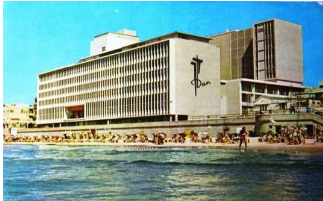
Figure 51: L'hôtel Dan Tel Aviv et le bord de mer, une carte postale typique des années 50-60, construit entre 1950-1953 Architecte : Heinz Panhal. Source: AII
