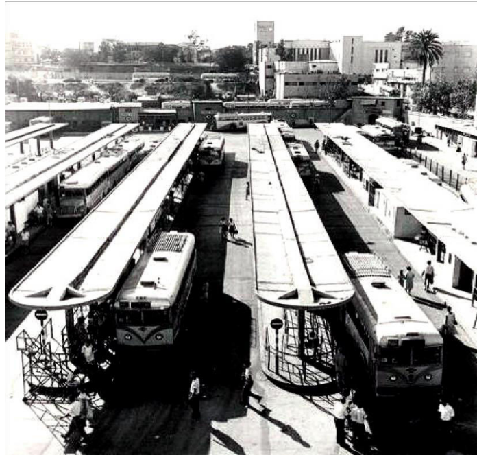
Figure 43: Les quais de la gare centrale d'autobus à Tel Aviv. Architecte Werner Witkower (avec Nahum Zelkind) 1934. Détruit le 2 août 2009. Photo : 1958, source inconnue. Tiré du dossier de documentation du département de la conservation des constructions à la mairie de Tel Aviv – Yafo.
