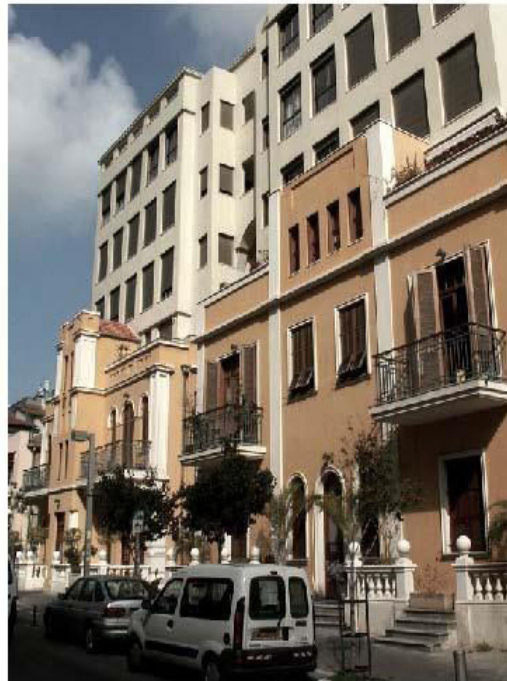
Figure 136: 13-15 Rue Balfour, architecte Elisha Rubin, 1994. En bas: la façade donnant sur la rue. En Haut : coupe (source : permis de construire, ADCIJ). photo : Jeremie Hoffmann
