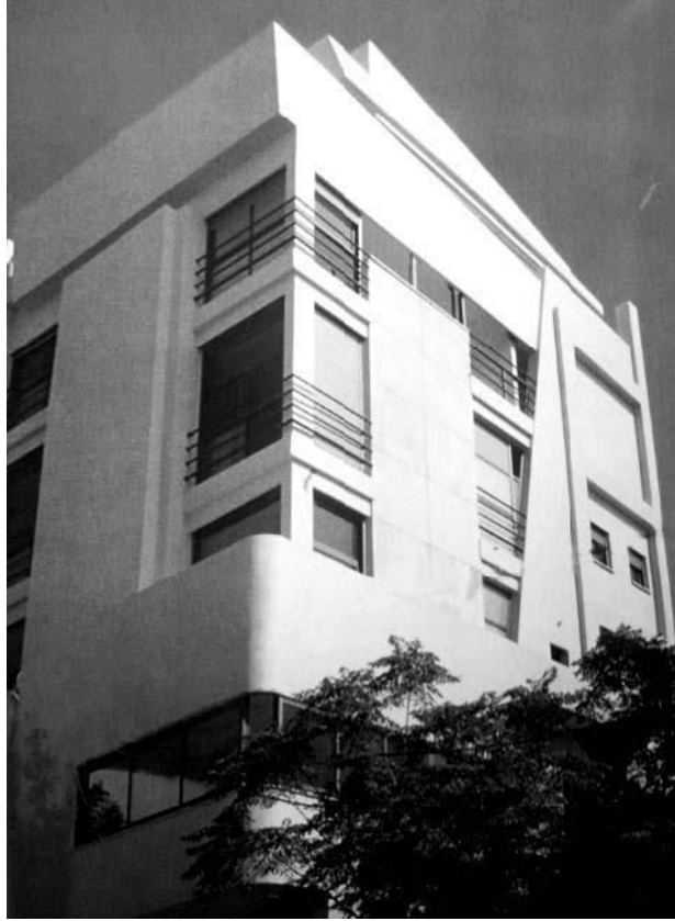
Figure 120: 30 rue Borokhov. Surélévation des trois étages supérieurs, Arcod Architectes, 1994, Photo de la collection des architectes. Non daté. Source: agence Arcod Architectures.
