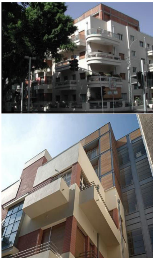
Figure 151 : Corniche flottante – 26 rue Hissin, A droite : Photo de façade du bâtiment à partir de l'ouest, extrait de Google Streets, 6.7.2013, A gauche: Façade de l'appartement sur le toit, extrait de permis de construire ADCTJ
