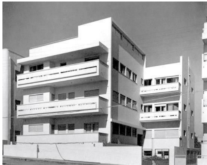
Figure 44: Composition libre de volumes, des balcons aérés et des appartements ouvrant plusieurs pièces sur le balcon. Les balcons de la maison Deblitski, 70 rue Ha 'Yarkon, 1934, architecte : Zéev Rechter. Photo : Yitzhak Kelter.
