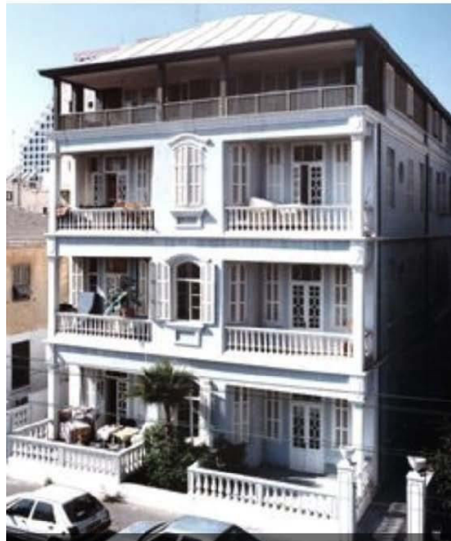
Figure 146: Etage en bois – 23 rue Guéula A gauche de haut en bas : L'illustration de l'immeuble. Illustrateur : Jérémie Hoffmann, 2013. Photo du bâtiment, de la collection de l'architecte. A droite : Deux façades, plan et coupe en largeur, extrait du permis de construire, source : ADCTJ
