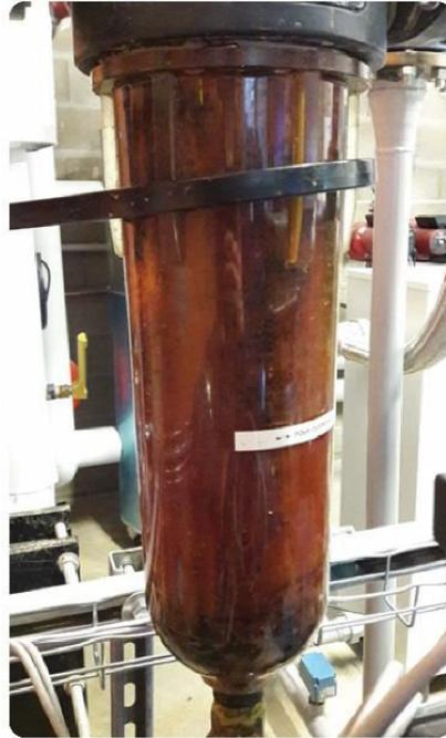
Figure 15 : Filtre à manchon colmaté par des oxydes métalliques (Burté, 2017)
