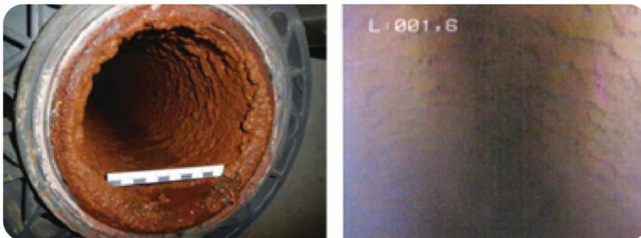
Figure 32 : Photographie d'une canalisation de l'installation ARHO5 reliée à l'échangeur (gauche) et extrait de l'inspection caméra du forage d'injection (droite) (source : Antea Group France)
