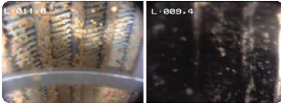
**Figure 64 : Extrait des inspections vidéo à la réception des ouvrages de pompage (gauche) et de rejet (droite) de SY2 (Source : Antea Group France)**
