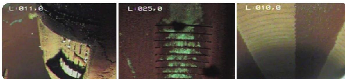
Figure 36 : Extrait de l'inspection caméra du forage de pompage (gauche et centre) et du forage de rejet (droite) de l'installation ARHI2 (source : Antea Group France)
