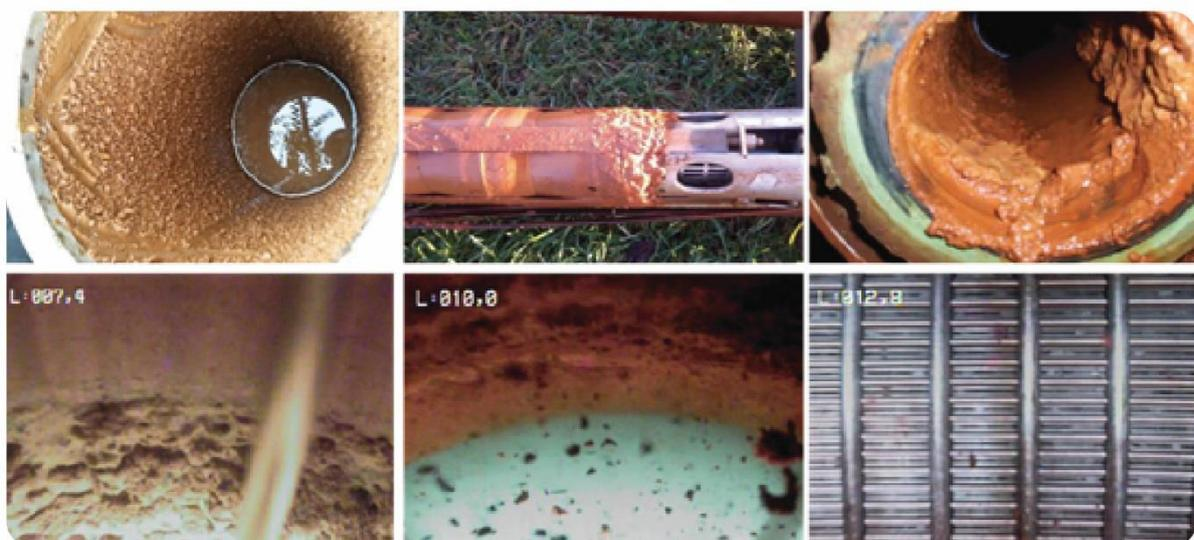
Figure 47 : Photographie du filtre à tamis (haut, gauche), de la pompe du forage de pompage (haut, milieu), de la canalisation en amont de l'échangeur thermique (haut, droite) et extrait de l'inspection caméra du forage de pompage (bas) de l'installation AAD1 (source : Antea Group France)
