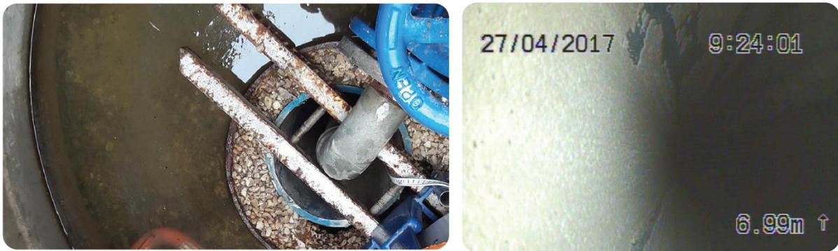
**Figure 104 : Cave d'avant puits inondée lors d'événements pluvieux. Par débordement, les eaux s'infiltrent dans le massif de gravier et s'introduisent dans le forage de réinjection générant des dépôts carbonatés sur la surface interne du tubage plein (Burté, 2017).**
