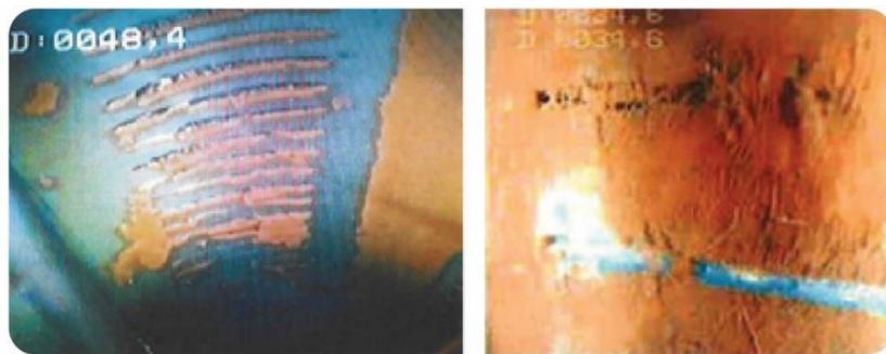
Figure 27 : Vidéo inspection des crépines du forage de pompage de CG2 (source : Antea Group France)
