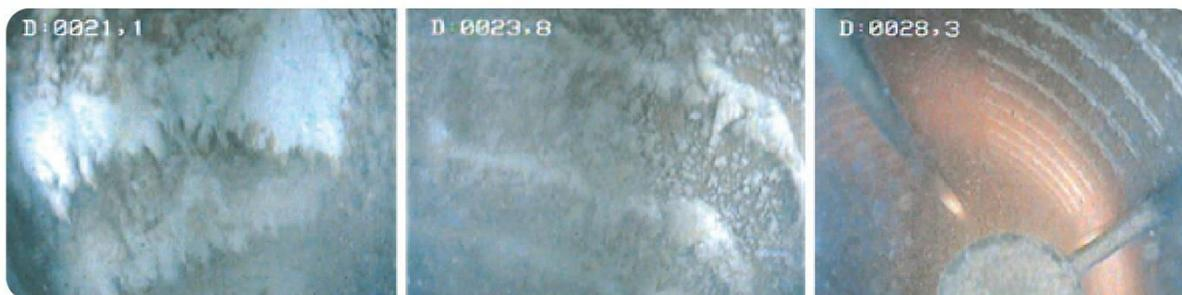
Figure 25 : Vidéo inspection des crépines des forages de CR3 (source : Antea Group France)
