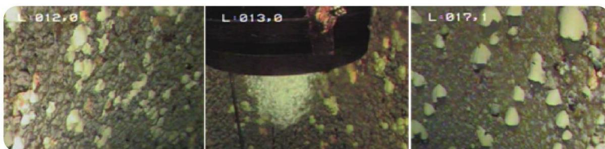
Figure 52 : Extrait des inspections vidéo du forage de rejet (12 ans après les premiers travaux de réhabilitation)
