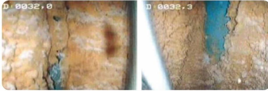
Figure 23 : Vidéo inspection des crépines des forages de CG2 (source : Sanfor)
