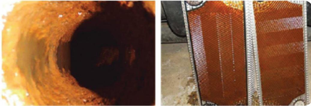
Figure 31 : Photographie d'une canalisation de l'installation ARHO3 reliée à l'échangeur (gauche) et des plaques de l'échangeur recouvert d'un dépôts d'oxydes ferriques (droite) (source : Antea Group France)
