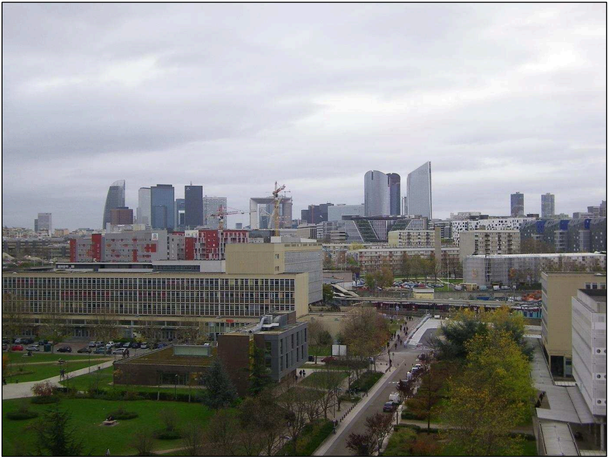
Source : Auteure, décembre 2015, vue depuis le bâtiment B, orientée Sud-Est.
