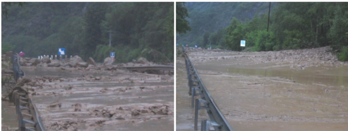
Figure 229 : Photographies de la crue de 2006 : obstruction du pont et débordement en amont en rive gauche avec dépôts de matériaux sur la chaussée (Source : RTM 38, ONF).
