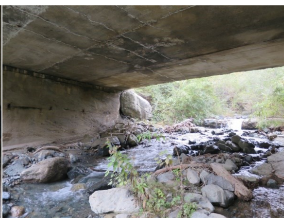
Figure 336 : Passage du torrent de la Vaudaine sous le pont de la RD 1091, vu depuis l'aval (Source : RTM 38, ONF).
