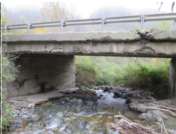
Figure 334 : Passage du torrent de la Vaudaine sous le pont de la RD 1091, vu depuis l'amont (Source : RTM 38, ONF).
