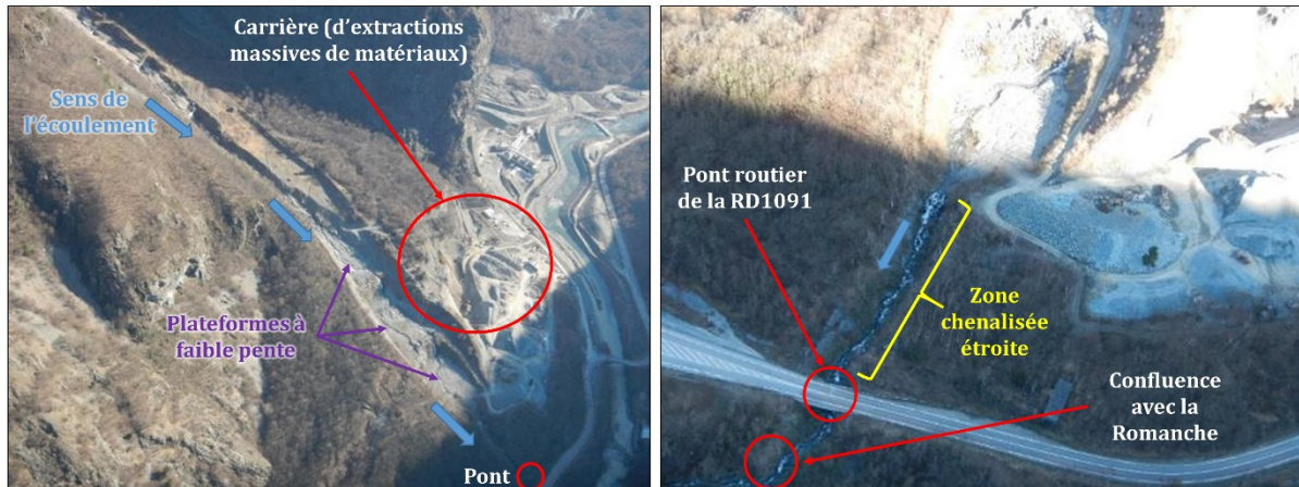
Figure 228 : Photographies aériennes de la partie aval du bassin versant de la Vaudaine : vue sur les plateformes à faible pente et la carrière (image de gauche) ainsi que sur la zone du pont routier et la confluence avec la Romanche (image de droite) (Source : RTM 38, ONF).
