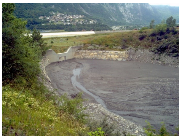
Figure 175 : Plage de dépôt du ruisseau de Claret, près de la commune de Saint-Julien-Mont-Denis en juillet 2012 (RTM 38, ONF).
