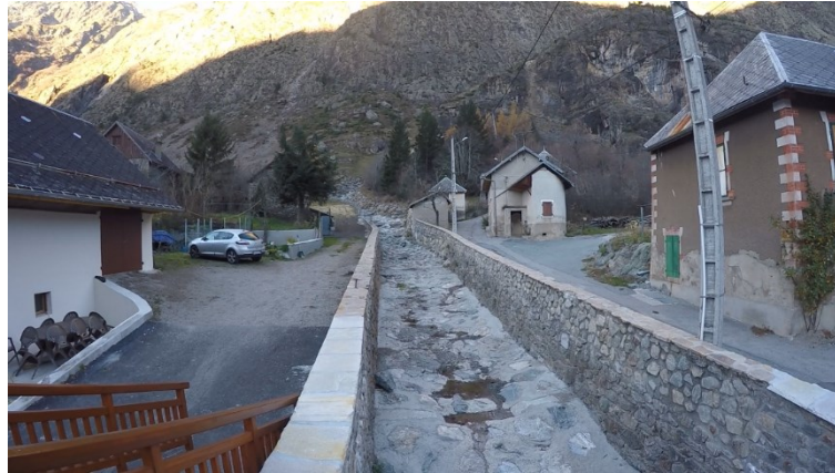
Figure 60 : Chenal d'écoulement du village de Chantelouve en novembre 2015 (ICube, 3D Eau).
