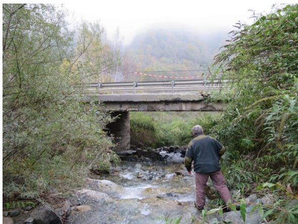
Figure 333 : Pont de la RD 1091 vu depuis l'amont du talweg du torrent de la Vaudaine (Source : RTM 38, ONF).
