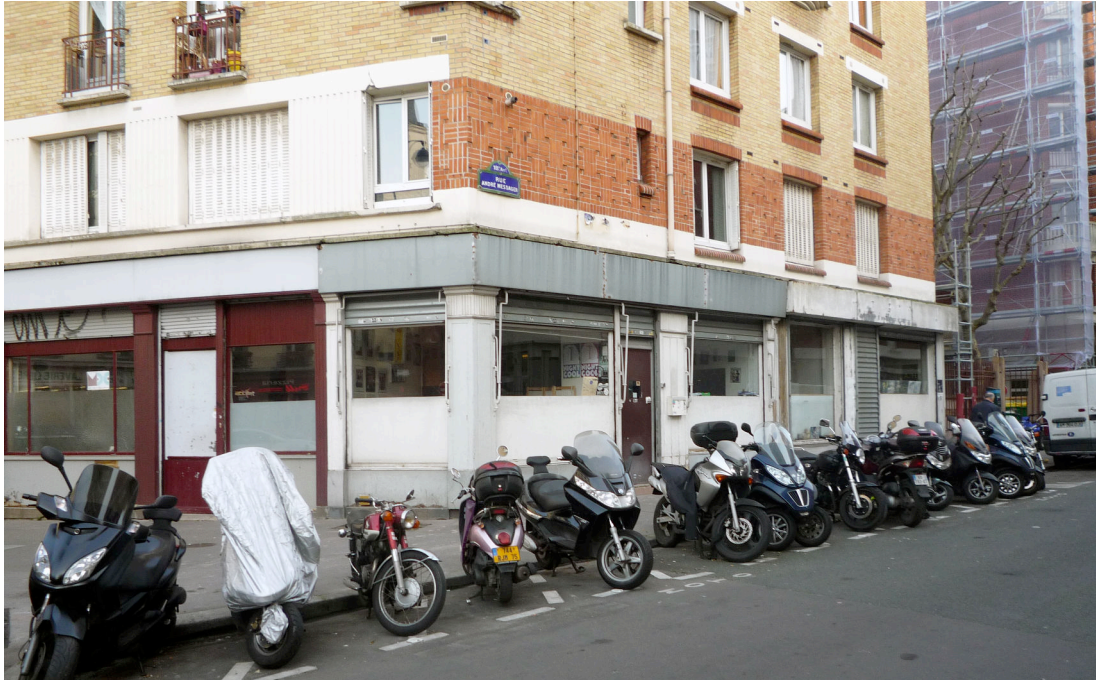
Figure 24 : La plupart des boutiques, en rez-de-chaussé d'immeubles dégradés, privilégient le fonctionnel à l'amélioration esthétique des façades. Source : B. Lefèvre - 2015
