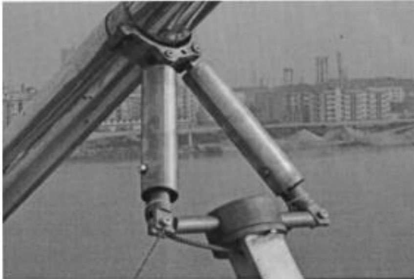
Figure 17 : Installation d'amortisseur avec du fluide MR sur le pont du lac de Dongting en Chine, adapté de [117].
