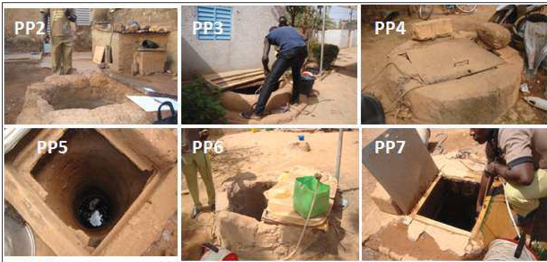
Figure 1. 18 : Etat actuel des puits particuliers dans les concessions de Zogona.
