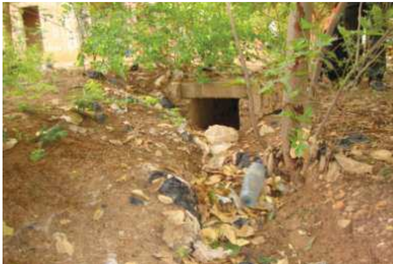
Figure 1. 16 Embouchure d'un petit canal d'assainissement à 20 m du canal de l'université.
