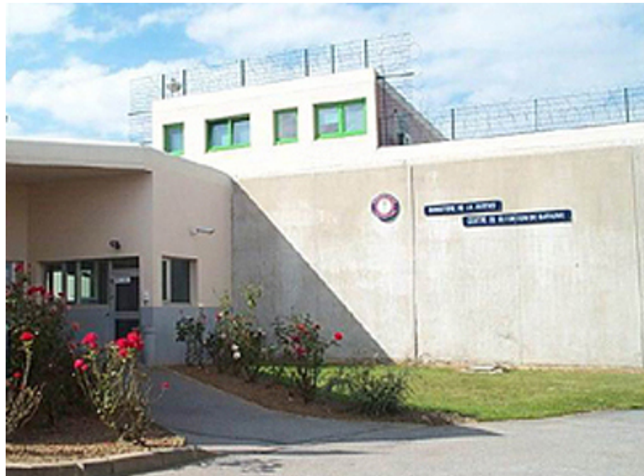
Entrée du CD de Bapaume vue de l'extérieur.
