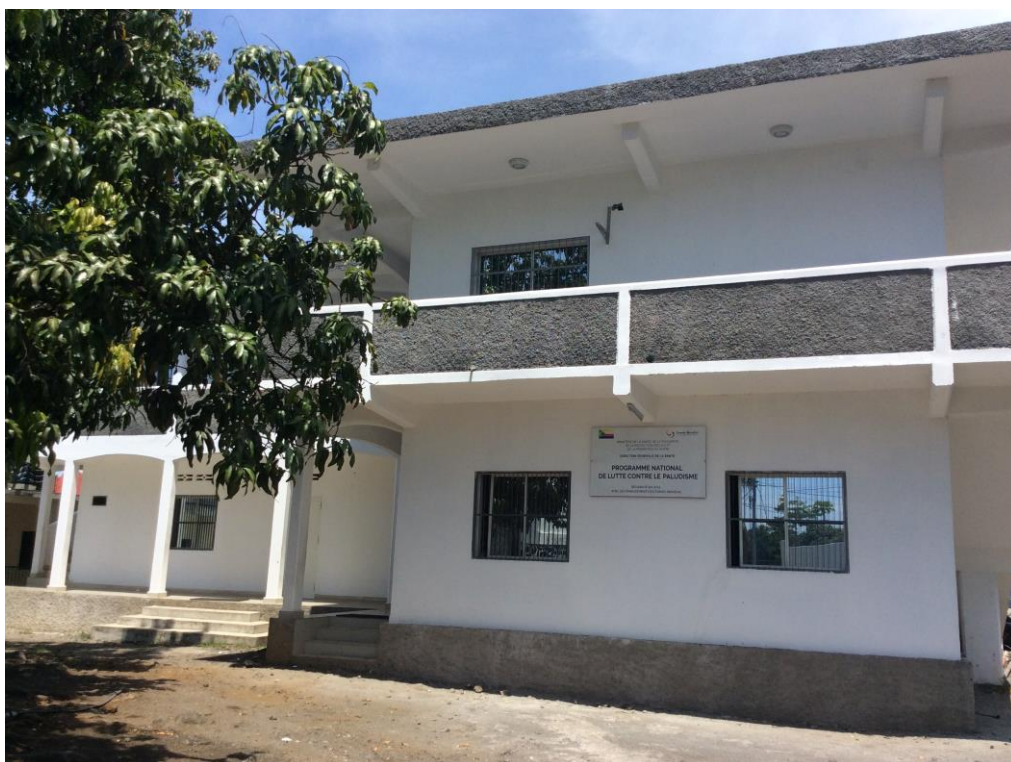
Photographie 8 : Bâtiment du Programme National de Lutte contre le Paludisme, sis la Corniche, Moroni
