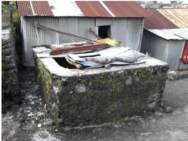
Photographie 26 : Citerne avec gouttière en tôle en dehors du ménage à Hassendje à la Grande Comore
