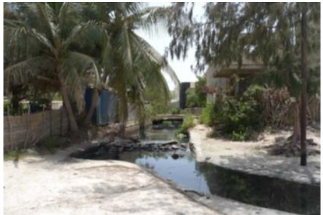
Rejets d'eaux usées domestiques
