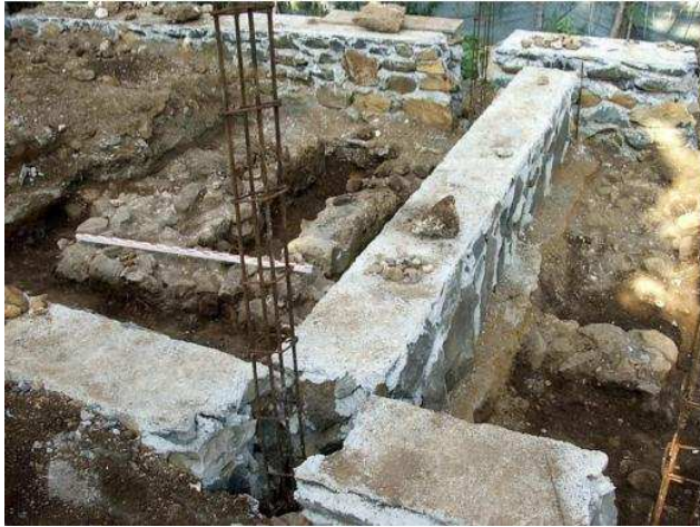
Figure 108 Contexte de la fouille de 2006 : aperçu des structures archéologiques sous les soubassements d'une habitation de particulier en cours de construction. Cliché, M. Pauly 2006.
