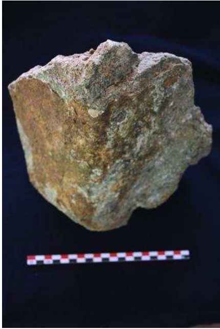
Figure 285 Enduit mural présentant un angle et provenant des décombres de la porte de l'enclos villageois, cliché M. Pauly 2012.
