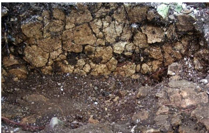
Figure 136 Exemple d'enduit mural conservé sur le mur oriental de la pièce 027. Cliché M. Pauly 2007.
