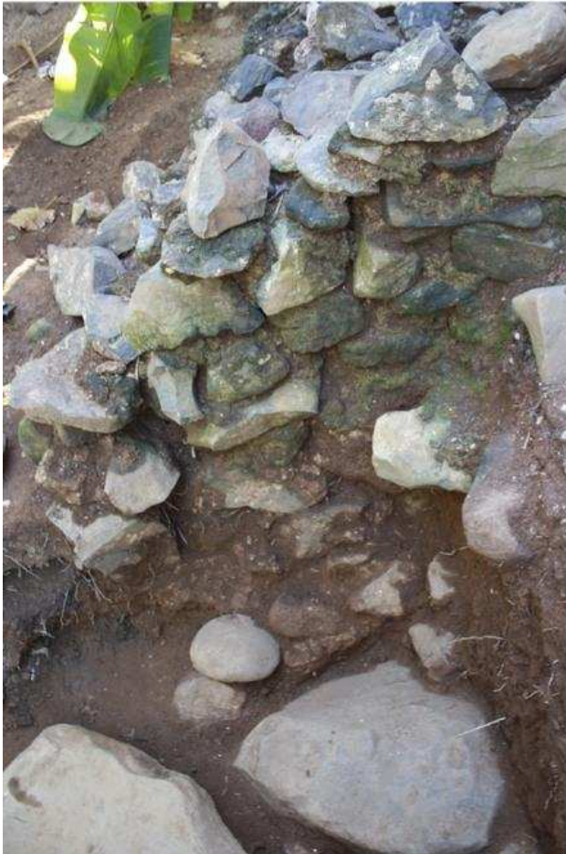
Figure 82 Aperçu, depuis l'intérieur du passage de la porte, du parement du piédroit occidental. Ce massif maçonné qui présente plusieurs états de construction présente une conservation médiocre comparée au piédroit oriental, cliché M. Pauly, 2012.
