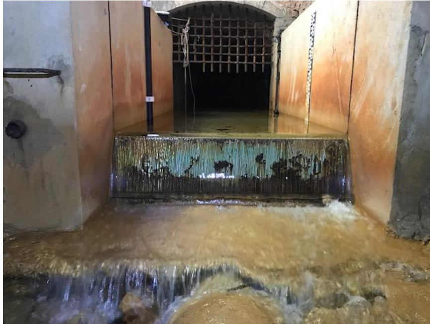
Figure 2-8 Galerie de la source Saint-Antoine. Photographie prise le 04 aout 2017 (T.Lamarque), débit historiquement très faible ( \approx 10 L/s, la retenue de Dardennes est vide et le Las est à sec).
