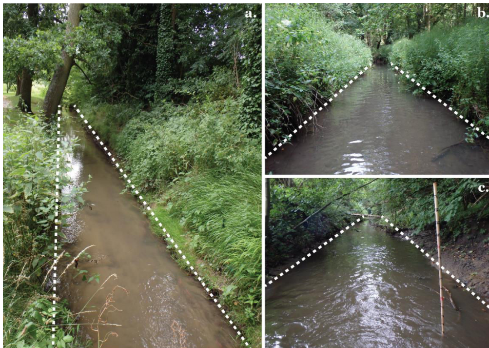
Figure 4.25 : Exemples de sections chenalisées du lit de la Mérantaise encore visibles aujourd'hui.
