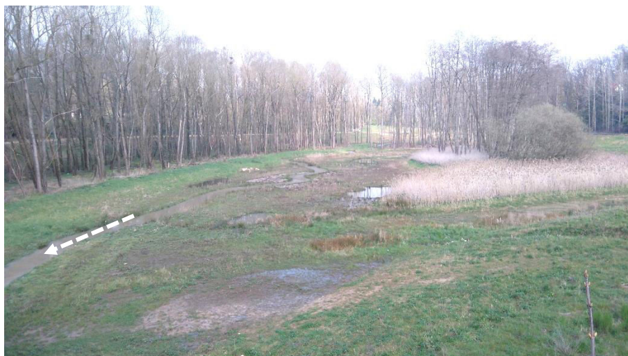
Figure 8.6 : Configuration actuelle de la retenue du bassin de la Mérantaise à Gif. Aménagement d'une zone humide et d'un chenal « restauré » (crédits : D. Fekih, 2016)
