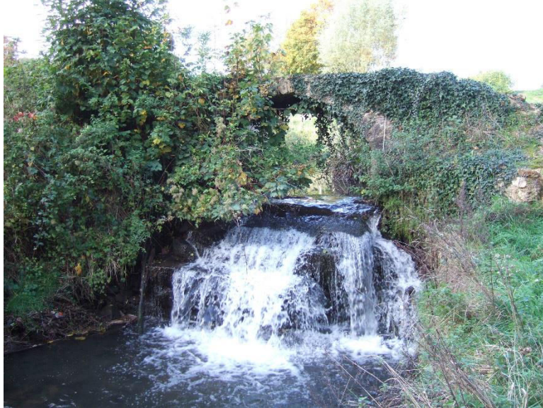
Figure 4.7: Le seuil d'Ors dans son état actuel. Vue depuis l'aval.
