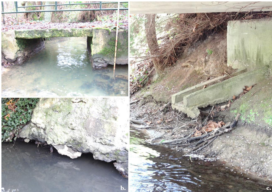
Figure 7.14 : Exemples d'ouvrages latéraux porteurs de marques d'incision. a. culées de ponts ; b. muret ; c. buses.
