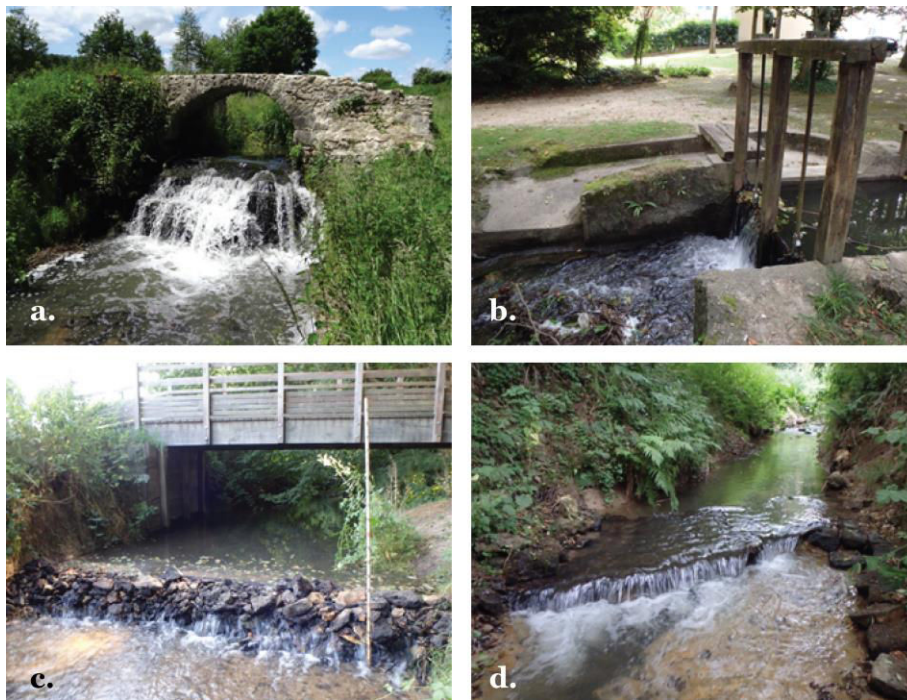
Figure 3.14 : Exemples d'obstacles à l'écoulement. a. chute du moulin d'Ors à Châteaufort ; b. système de vannage dans le parc du CNRS de Gif-sur-Yvette ; c. petit seuil anthropique constitué de blocs de pierres ; d. Section du collecteur d'eaux usées de la vallée de la Mérantaise traversant la rivière. (Crédits photo : M. Jugie)
