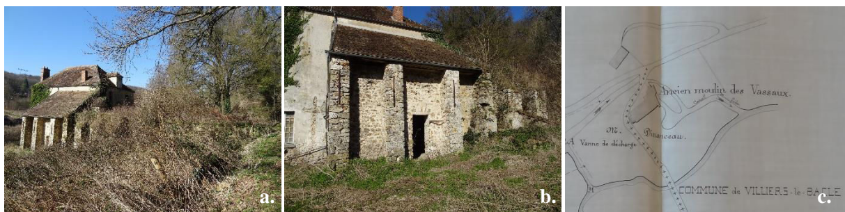
Figure 4.9 : Le moulin des Vassaux désormais abandonné (clichés de 2014). a. vue du moulin depuis l'ancien bief perché ; b. vue de l'ancienne salle des machines ; c. extrait d'un plan local illustrant le fonctionnement du complexe du moulin des Vassaux au XIX ème siècle (sources : ADY 7S 115).
