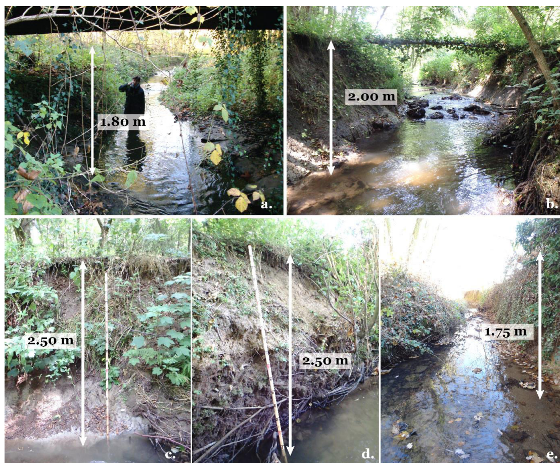
Figure 7.2: Exemples de hauteurs de berges importantes sur le cours de la Mérantaise (Crédits photo : M. Jugie).
