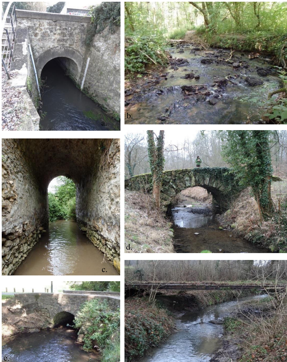
Figure 4.21 : Exemple de ponts et passerelles présents tout le long de la Mérantaise. a. pont de la D938 à Châteaufort ; b. ruines des « Ponts de Pierre », en amont des Vassaux ; c. pont de la route d'Ors ; d. pont au fond de Mérencis ; e. vieux pont à l'aval du moulin Neuf ; f. passerelle vestige du domaine d'Ors (XIX ème -XX ème ). (Crédits photos : M. Jugie)
