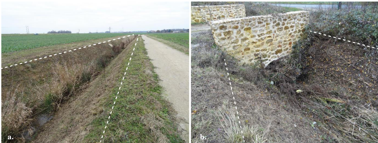
Figure 6.9 : Vues de la rigole de Châteaufort (Crédit photo : M. Jugie, 2013).
