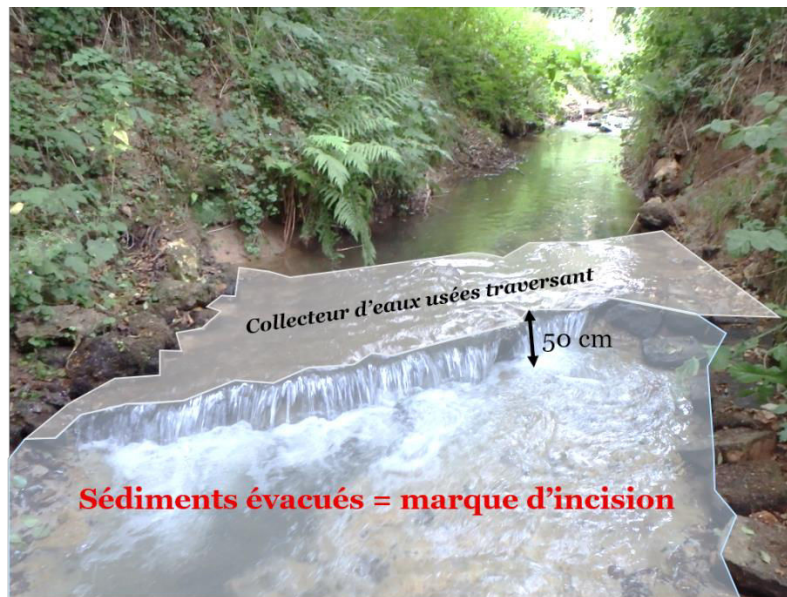
Figure 7.3: Exemple du surplomb du collecteur d'eau usées de la vallée de la Mérantaise (canalisation 2).
