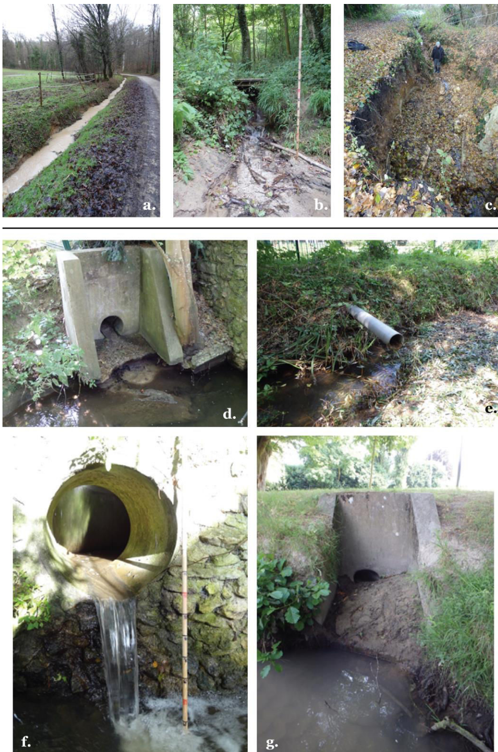
Figure 3.13 : Exemples d'affluents (a. fossé ; b. ruissellement de sources des versants ; c. ravines) et de buses et drains artificiels (d. et f. exutoires du réseau de drainage des eaux pluviales urbaines ; e. tuyaux de jardin ; g. buse obstruée). (Crédits photo : M. Jugie)
