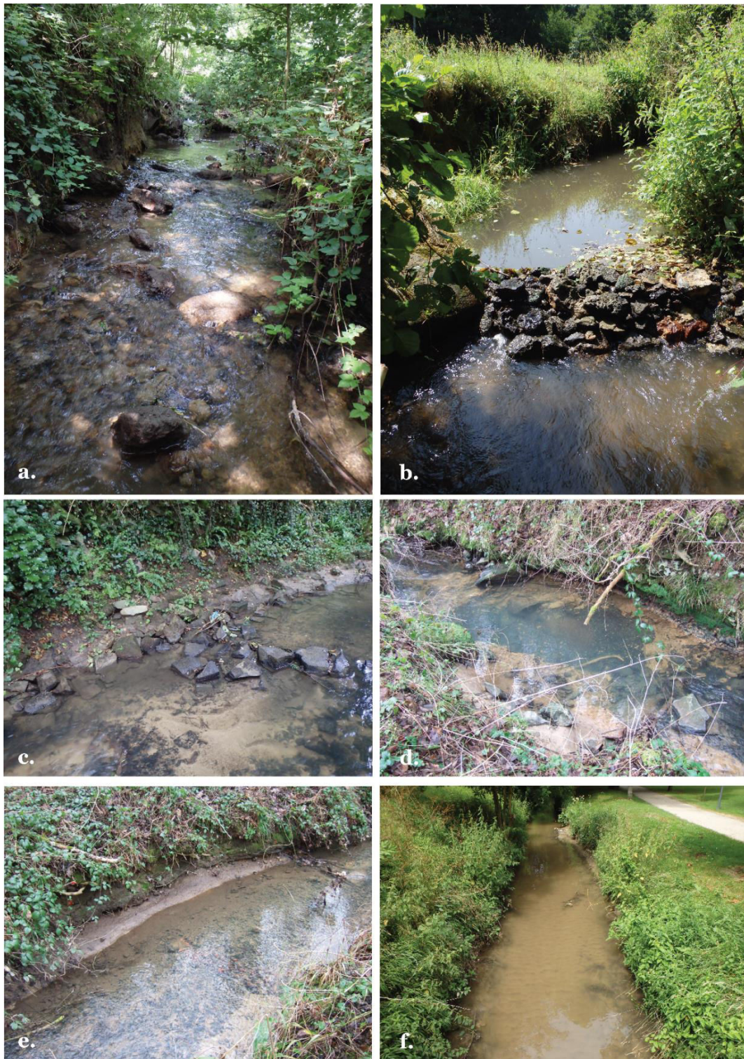
Figure 2.7 : Exemple de substrat et de charge sédimentaire rencontrés dans le chenal de la Mérantaise. a. blocs, sur substratum argileux compact ; b. et c. blocs constitués artificiellement en seuil, issus d'un muret effondré (c.) ; d. argile très compact à l'affleurement ; e. charge solide composant l'essentiel des radiers du chenal, charge immobile ; f. ensablement à l'aval de la Mérantaise. (Crédits photo : M. Jugie)
