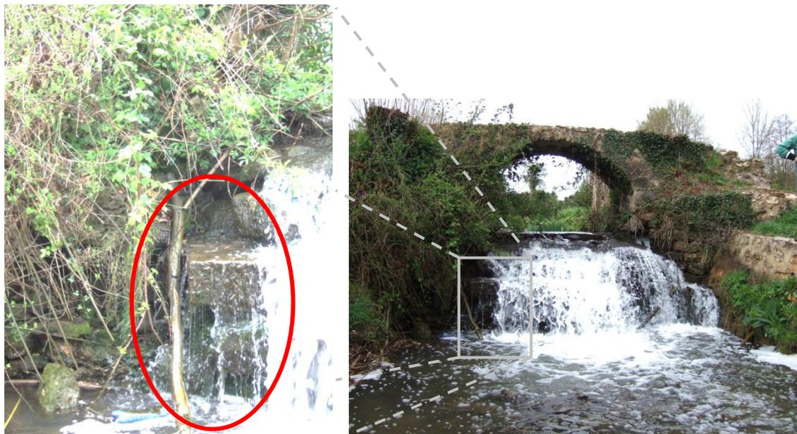
Figure 7.4: Marques d'affouillement des piles du seuil d'Ors
