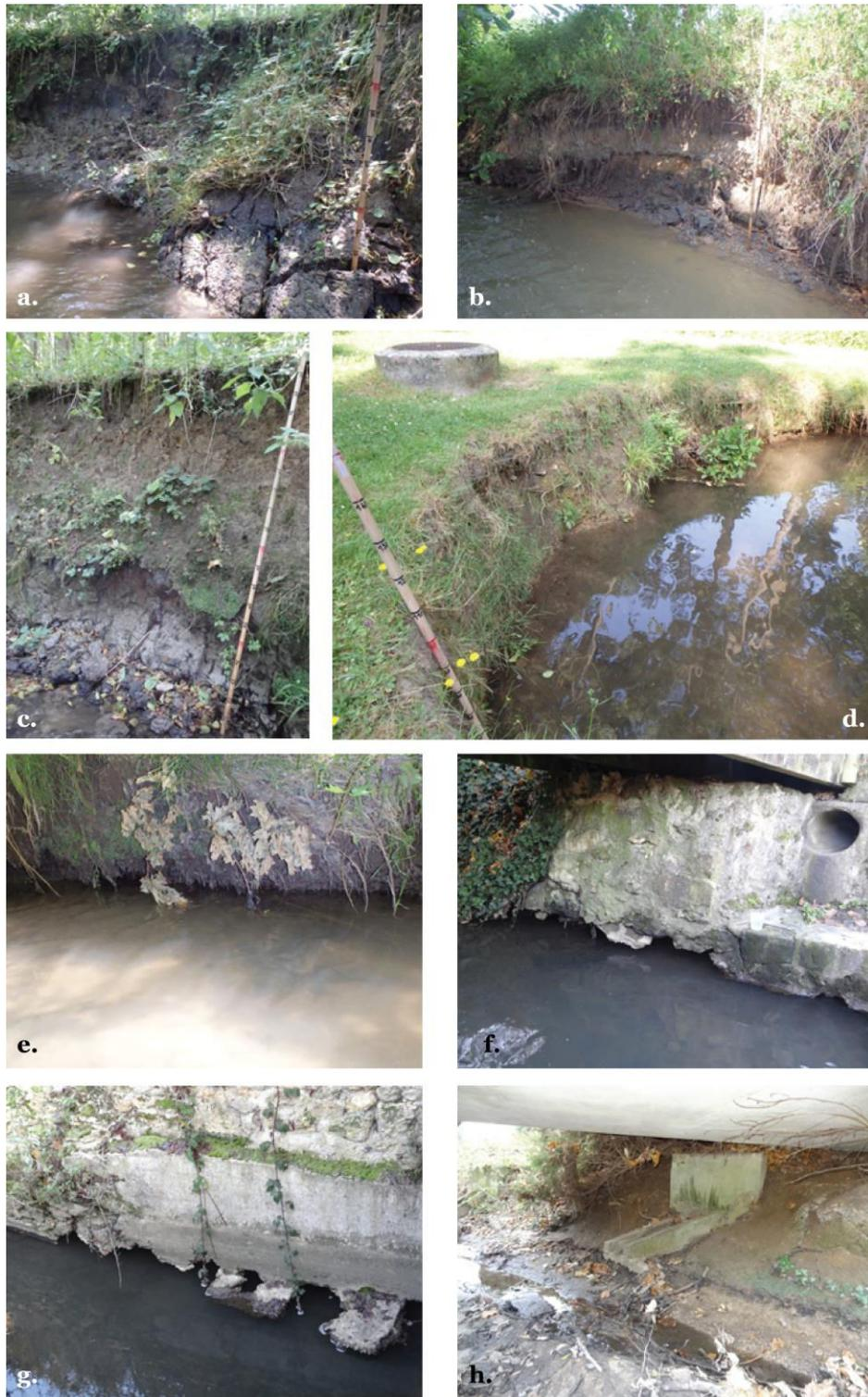
Figure 3.11 : Exemples de traces d'érosion de berge active (a., b.) ou potentielle (c., d.) ; ainsi que d'affouillement de berge (e.) ou d'ouvrages latéraux (f., g., h.). (Crédits photo : M. Jugie)
