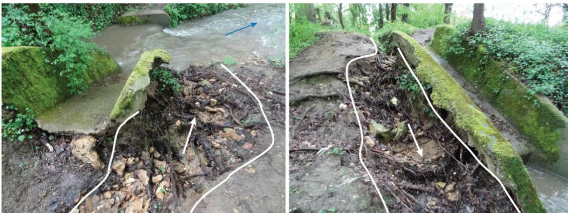
Figure 8.10 : Buse déconnectée des écoulements à cause de l'érosion de la ravine en amont.
