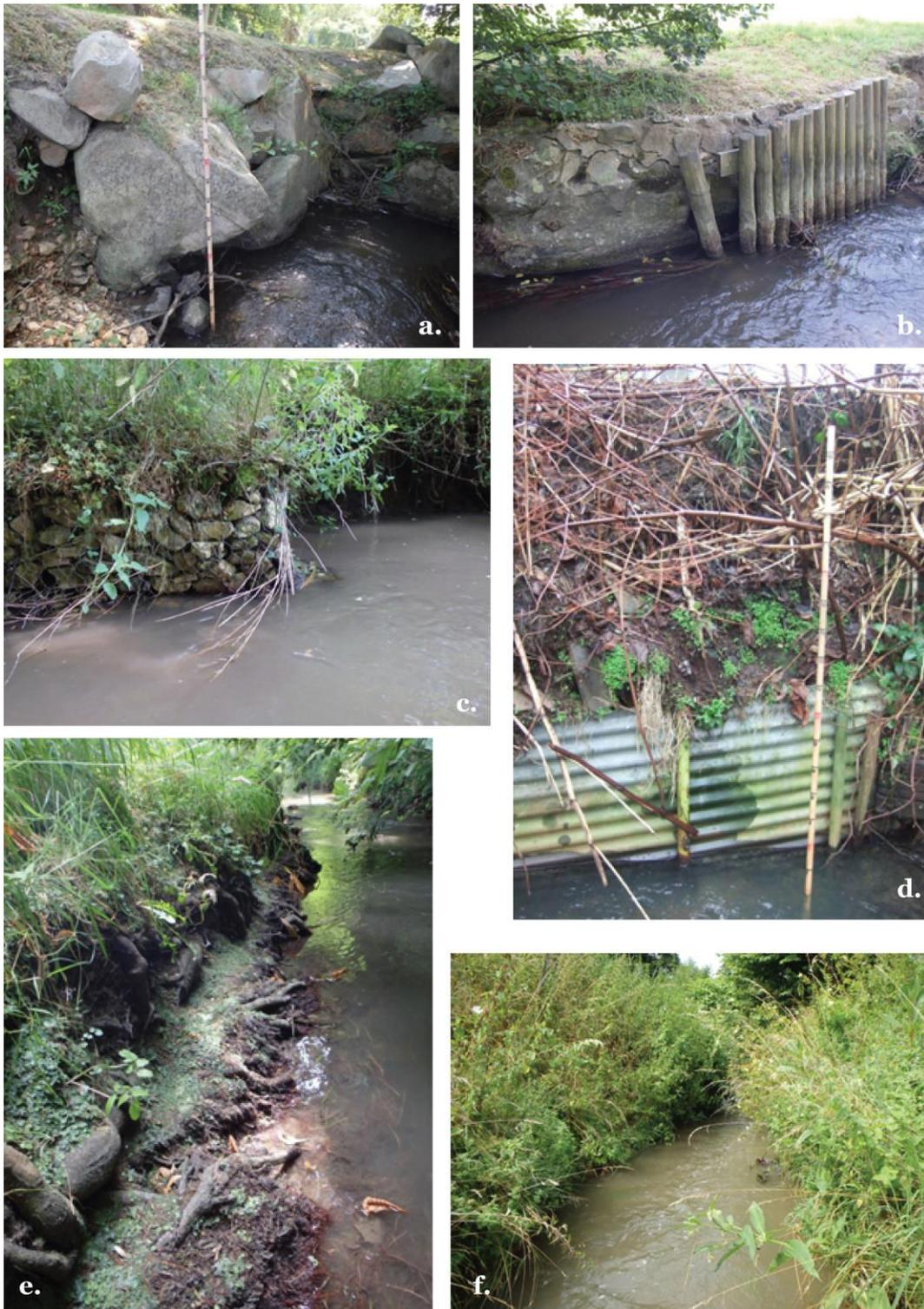
Figure 3.12 : Exemples de protections de berges anthropiques (a. blocs, b., muret et bois, c., gabions, d. tôle) et « naturelles » (e., racines, f. végétation dense). (Crédits photo : M. Jugie)
