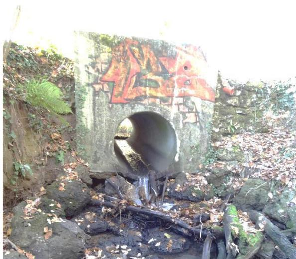
Figure 7.5: Buse implantée transversalement au lit de la Mérantaise (amont), portant des marques d'affouillement et d'incision.
