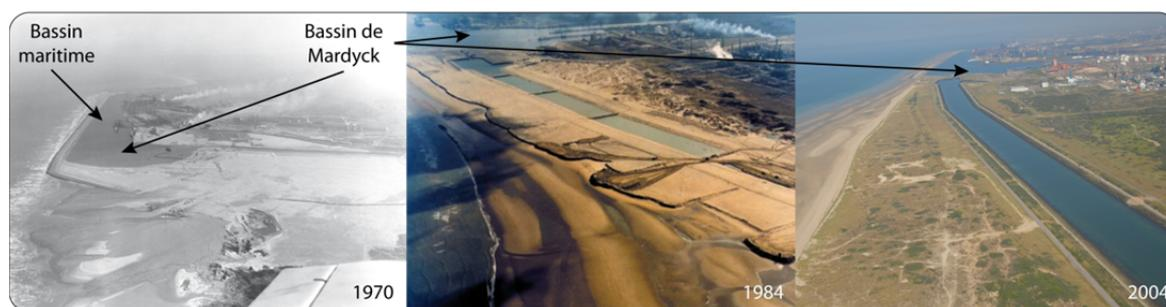
Figure IV.10 Photographies prises avant (1970), pendant (1984) et après (2004) le creusement du canal des dunes (sources : archives du GPMD) (Tresca, 2013)
