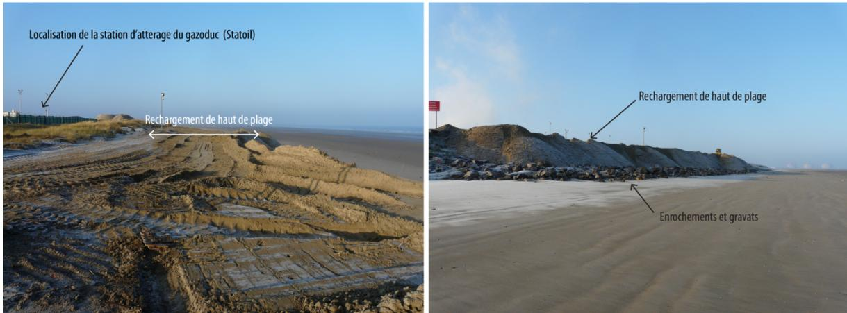
**Figure VIII.16 Rechargement de haut de plage pour conforter le secteur de la station d'atterrage du gazoduc**
