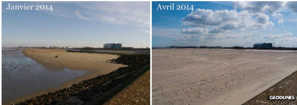
Figure VI.8 Etat du site avant (A) et après (B) la deuxième étape des travaux de rechargement sédimentaire (source : A. cartier)
