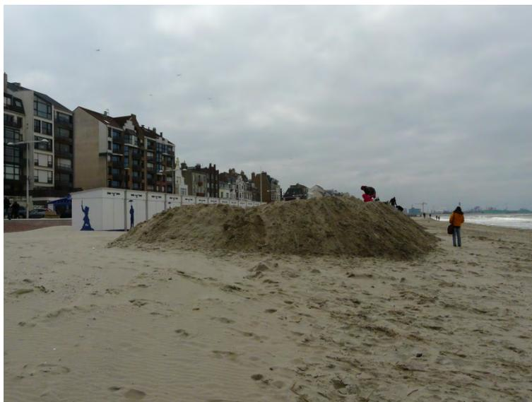
**Figure IV.16 Photographie prise le 22/03/2015 de bourrelets sableux modelés pour protéger des hauts niveaux d'eau les cabines de plage situées en arrière pendant les grandes marées (photo : Alexandra Spodar)**
