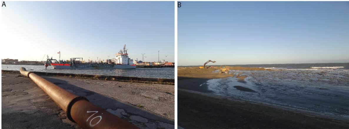
**Figure VI.5 Travaux de rechargement de plage en janvier 2012 (Etape 1/2) (source : Antoine Tresca) - A) Drague connectée aux conduites de refoulement - B) Aperçu du régalaage du sable sur la plage par les engins de terrassement**
