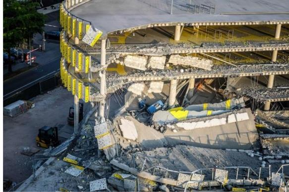
**Figure 1-2** Effondrement partiel d'un bâtiment aux Pays-Bas sous contraintes de cisaillement
