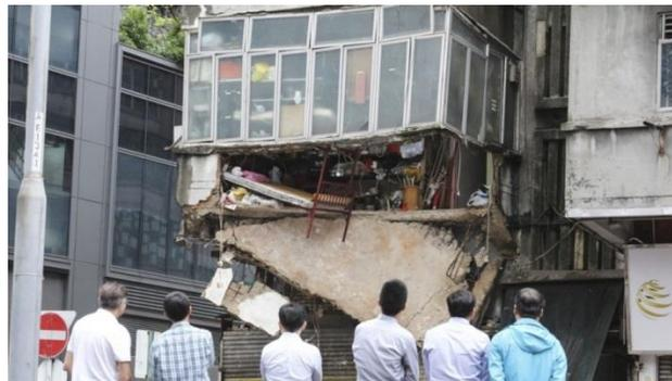
**Figure 1-3** Effondrement d'un balcon en cisaillement à Hong Kong en Juin 2017
