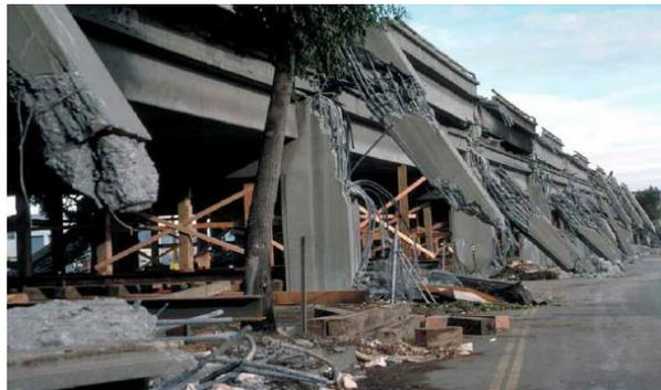
**Figure 1-1** Rupture des piliers d'un pont à Kobe au Japon suite à un séisme en 1995
