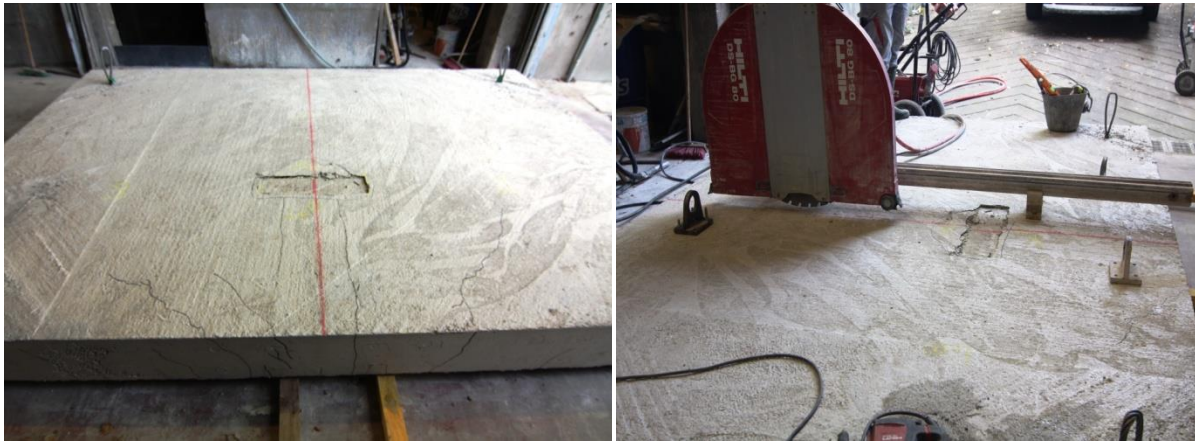
Figure 4-9 Sciage de la dalle S14
