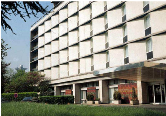
figure 162 photo d'un immeuble (exemple tiré de la documentation d'OpenCv 31 )
