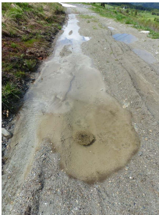
Figure 40 : Exemple de zone de reproduction de petite taille : une ornière située sur une piste de montagne dans la station des Arcs (Savoie).
