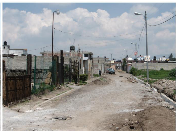
Photo 6.14. Santa Maria Ixtacalco, Cuautitlán, Etat de México [2011] Pose de l'adduction d'eau et des égouts et construction des trottoirs
