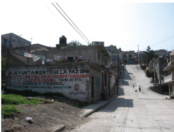
Photo 6.13. Ampliación Jorge Jiménez Cantú, La Paz, Etat de México [2011] Revêtement de la chaussée. "Mairie de La Paz 2009-2012. Construction du pavement hydraulique. Tronçon de la rue Puerto Acapulco à Puerto Angel"
