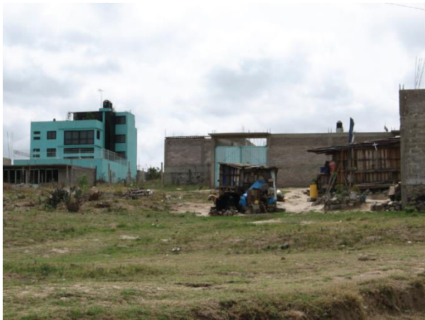
Photo 8.5. Lomas San Sebastián, La Paz, Etat de México, 2011. Grande maison bleue à 4 niveaux en location, jouxtant des parcelles en cours de lotissement. A droite, présence de maisons au premier niveau construit en dur. En face, construction entourée d'une haute enceinte. Mais aussi, présence de baraquements de fortune - pour le gardiennage des parcelles (chien de garde) - construits en matériaux de récupération .
