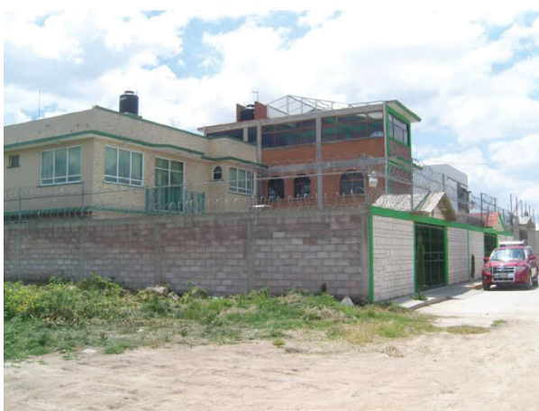
Photo 8.9. Tlaxculpas, Cuautitlán, Etat de México, 2011. Très grande maison récente (2009) d'un propriétaire originaire du DF. Construction achevée de 3 niveaux en matériaux de qualité, et efforts de protection de l'extérieur (murs élevés et 3 niveaux de barbelés)
