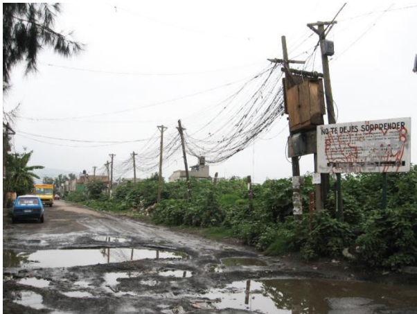
Photo 6.5. Ampliación La Conchita Zapotitlán, Tláhuac, DF [2011] Le décalage entre les interdictions et les faits. Panneau officiel de délimitation du sol de conservation (et interdiction de lotissement) jouxtant un tableau électrique illégal alimentant le quartier
