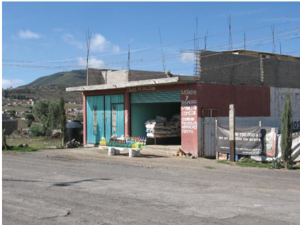
Photo 8.3. Lomas San Sebastián, La Paz, Etat de México, 2010. Logement, commerce et atelier agricole de Monsieur DS., arrivé en 2000. Construction sur un seul niveau en 2010, mais élévations prévues : murs en parpaings et chapes en béton. Murs de façade peints.
