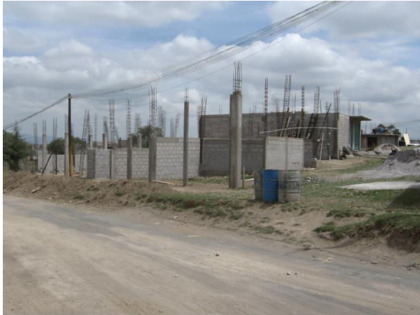
Photo 8.1. Lomas San Sebastián, La Paz, Etat de México, 2010. Fondations de maisons en construction au sein d'un "projet de logement" pour de nouveaux acquéreurs, résidant encore ailleurs.
