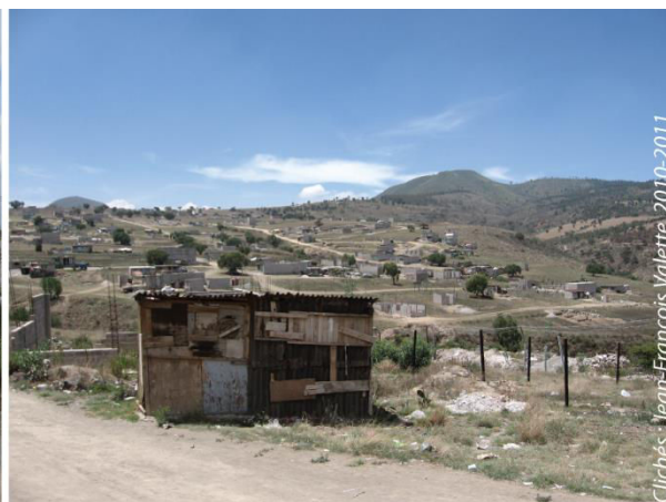
Photo 8.2. Lomas San Sebastián, La Paz, Etat de México, 2010. Maison de fortune occupée depuis 2009 : murs en planches, tôles et matériaux de récupération, toit en tôles. Logement provisoire permettant d'attester de l'occupation et de la surveillance de la parcelle sur laquelle les travaux de la maison en dur sont à peine commencés l'année suivante (2011).
