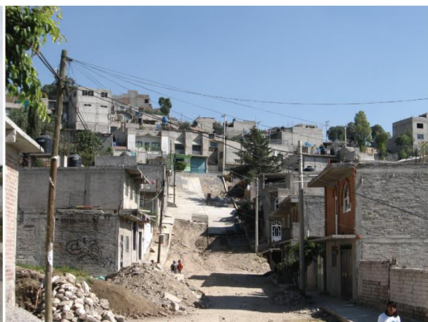
Photo 10.8. Travaux de construction des trottoirs et de revêtement des rues à Ampliación Jorge Jiménez Cantú, La Paz, Etat de Mexico [2010]
