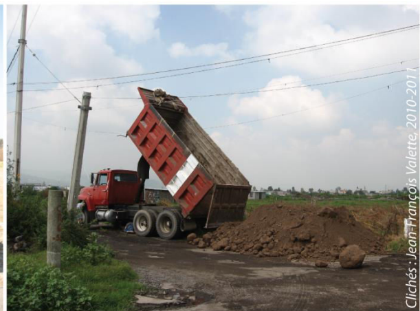
Photo 8.16. Tempiluli, Tláhuac, DF, 2010. Travaux de terrassement et de nivellement d'une rue par apports de gravats et de terre.
