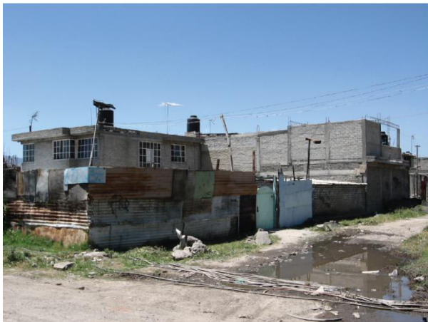
Photo 8.13. Ampliación La Conchita, Tláhuac, DF, 2010. Connexions illicites au réseau public d'eau par greffe de vannes sur les canalisations et transport par tuyaux d'arrosage. Problèmes de coupures et de conflits avec les voisins qui payent l'eau. Approvisionnement insuffisant et fragile. Sur les toits, présence de "tanques", réservoirs noirs pour stocker l'eau.
