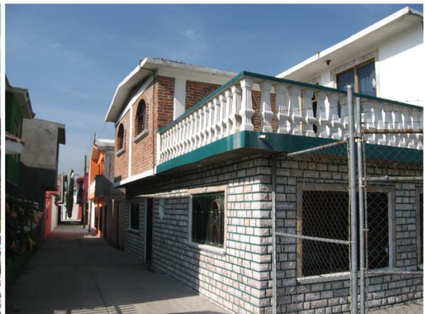
Photo 8.8. Tlaltepán, Cuautitlán, Etat de México, 2011. Maison de la famille R., originaire du village. Maison de naissance du chef de famille (1968). En 2011, construction achevée sur 2 niveaux en dur, plusieurs chambres et salons, éléments de décoration témoignant de l'ancienneté de la préoccupation esthétique pour le logement.
