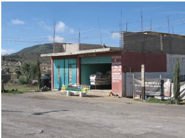
Photo 8.3. Lomas San Sebastián, La Paz, Etat de México, 2010. Logement, commerce et atelier agricole de Monsieur DS., arrivé en 2000. Construction sur un seul niveau en 2010, mais élévations prévue : murs en parpaings et chapes en béton. Murs de façade peints.
