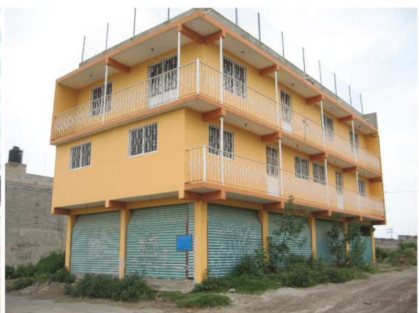
Photo 8.10. Lomas San Sebastián, La Paz, Etat de México, 2011. Immeuble d'appartements récent (2009) avec locaux commerciaux inoccupés. Construction achevée de 3 niveaux avec peinture.
