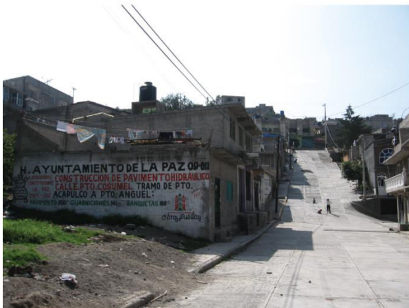
Photo 6.13. Ampliación Jorge Jiménez Cantú, La Paz, Etat de México [2011] Revêtement de la chaussée. "Mairie de La Paz 2009-2012. Construction du pavé hydraulique. Tronçon de la rue Puerto Acapulco à Puerto Angel"
