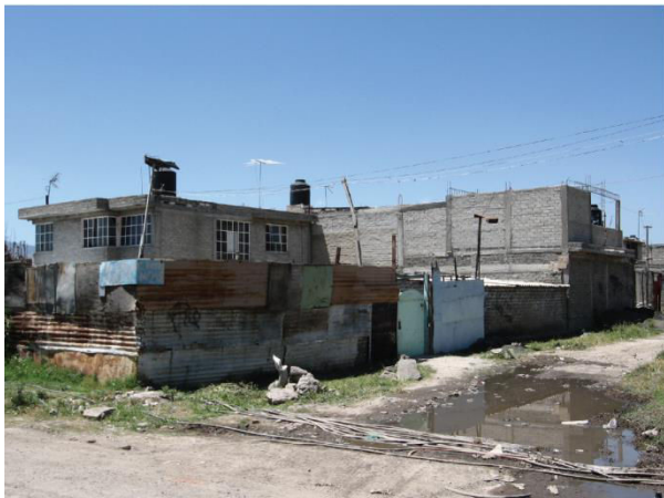
Photo 8.13. Ampliación La Conchita, Tláhuac, DF, 2010. Connexions illicites au réseau public d'eau par greffe de vannes sur les canalisations et transport par tuyaux d'arrosage. Problèmes de coupures et de conflits avec les voisins qui payent l'eau. Approvisionnement insuffisant et fragile. Sur les toits, présence de "tanques", réservoirs noirs pour stocker l'eau.
